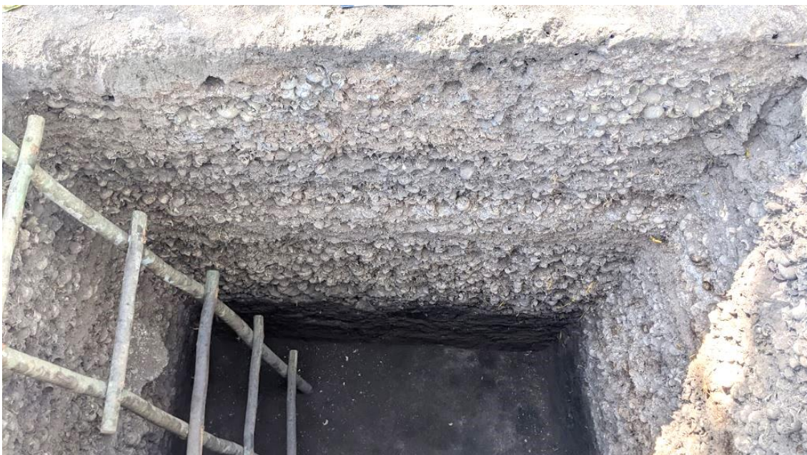
Figura 10: Trincheira afastada da escavação principal, 2022 (Foto: Sadie Weber).
