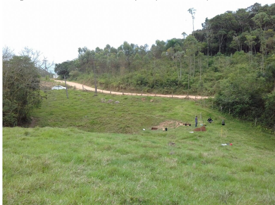
Figura 74: Morro da Cruz, área de implantação com escavação em andamento.
