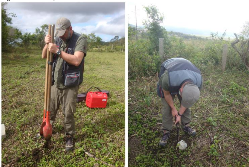
Figura 57: Instalação da base 1-ECZ.
