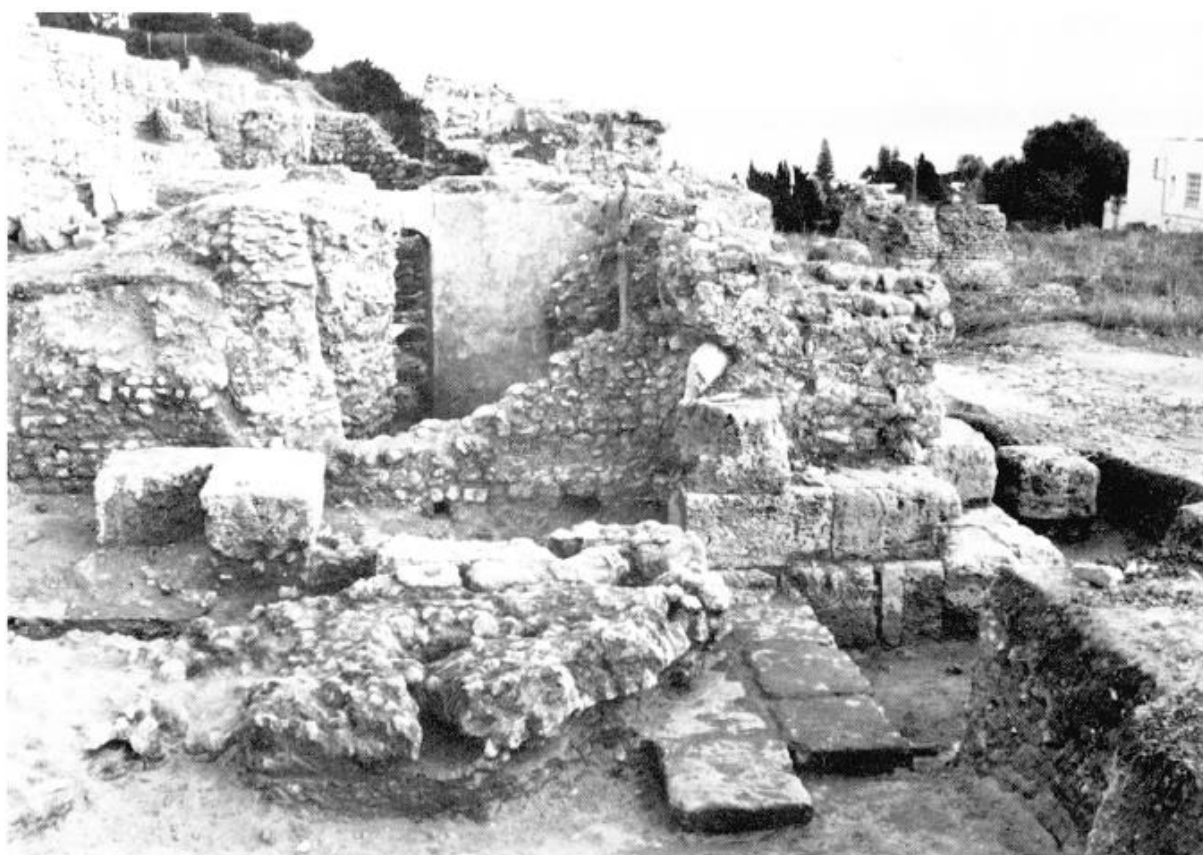
Figura 37: Edifício formando o ângulo entre o CM e o decumanus I sul visto do oeste. No primeiro plano, muro que desabou.
