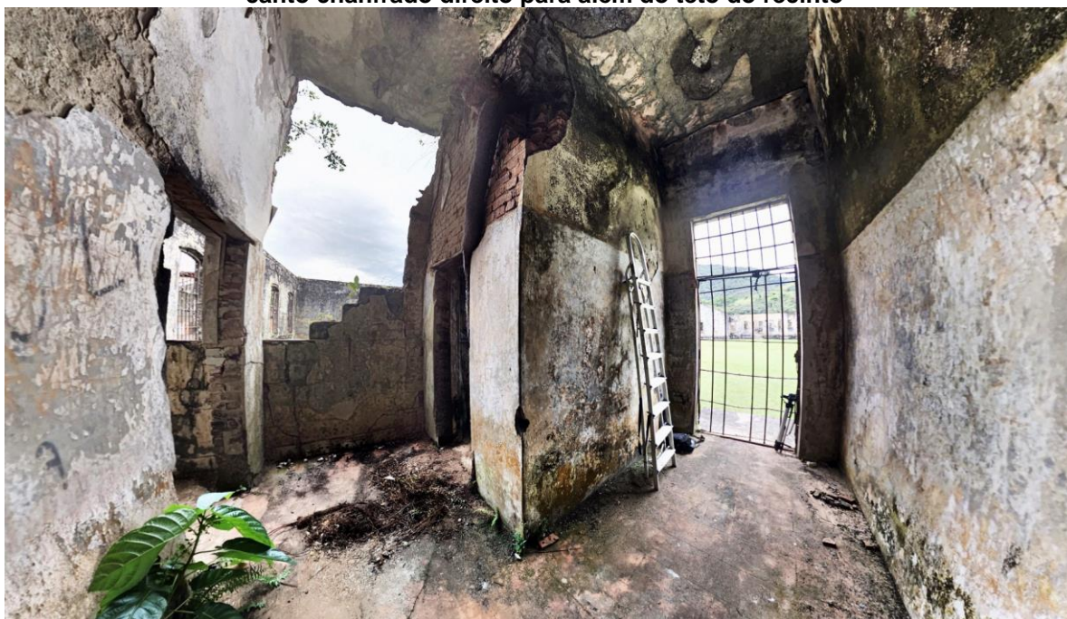
Figura 21: Vista noroeste do conjunto de solitárias em 180º. Do lado direito vista da entrada principal com grades originais (a) e do lado esquerdo vista parcial da cela 02 (b), parede conjugada ao Pavilhão 03 (c) e cela 01 (d) interceptada por tronco de árvore que cresce do canto chanfrado direito para além do teto do recinto
