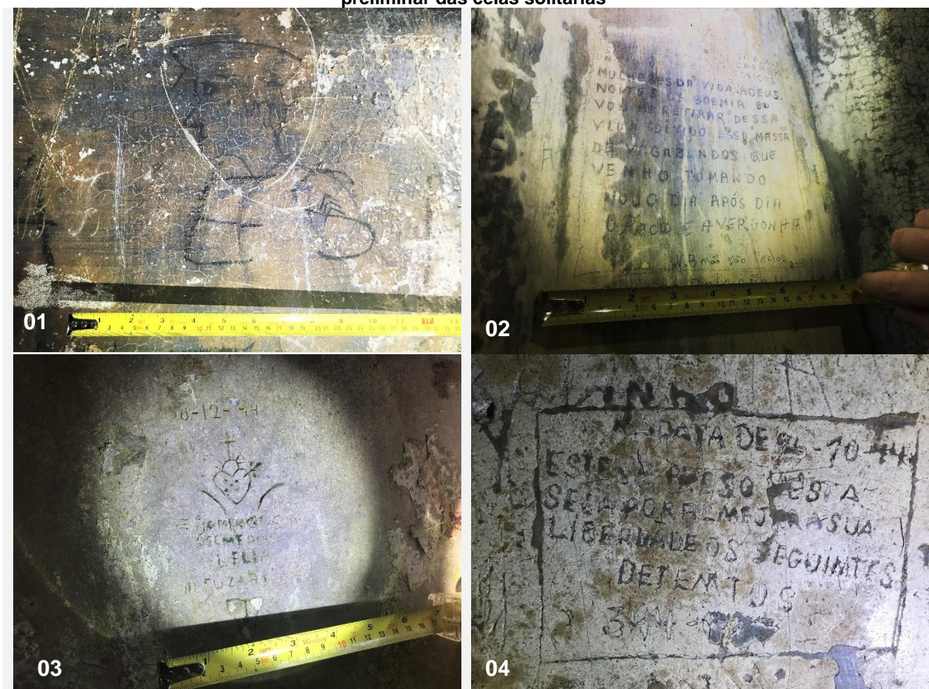
Fig. 01: Grafite figurativo 20 x 30 cm identificado em parede com patologia de alvenaria (eflorescência) [Solitária 04];
