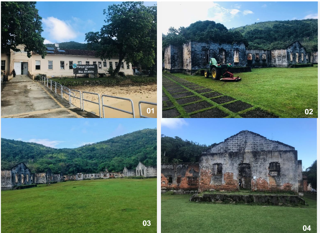
Figura 7: Prancha 01 - Estruturas do Presídio da Ilha Anchieta vistoriadas durante o levantamento preliminar
