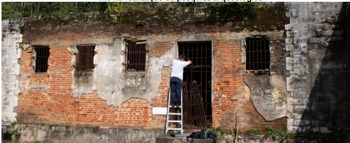
Figura 20: Vista externa do conjunto de solitárias. Destaque para abertura das estruturas com fito na realização da pesquisa arqueológica
