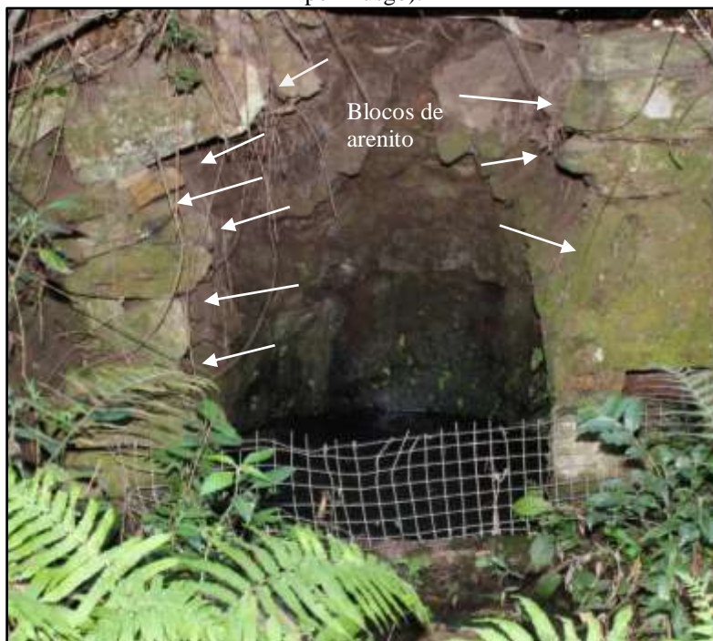
Figura 7. Detalhe construtivo da bica (empilhamento de blocos médios e grandes de arenito friável já cobertos por musgo).
