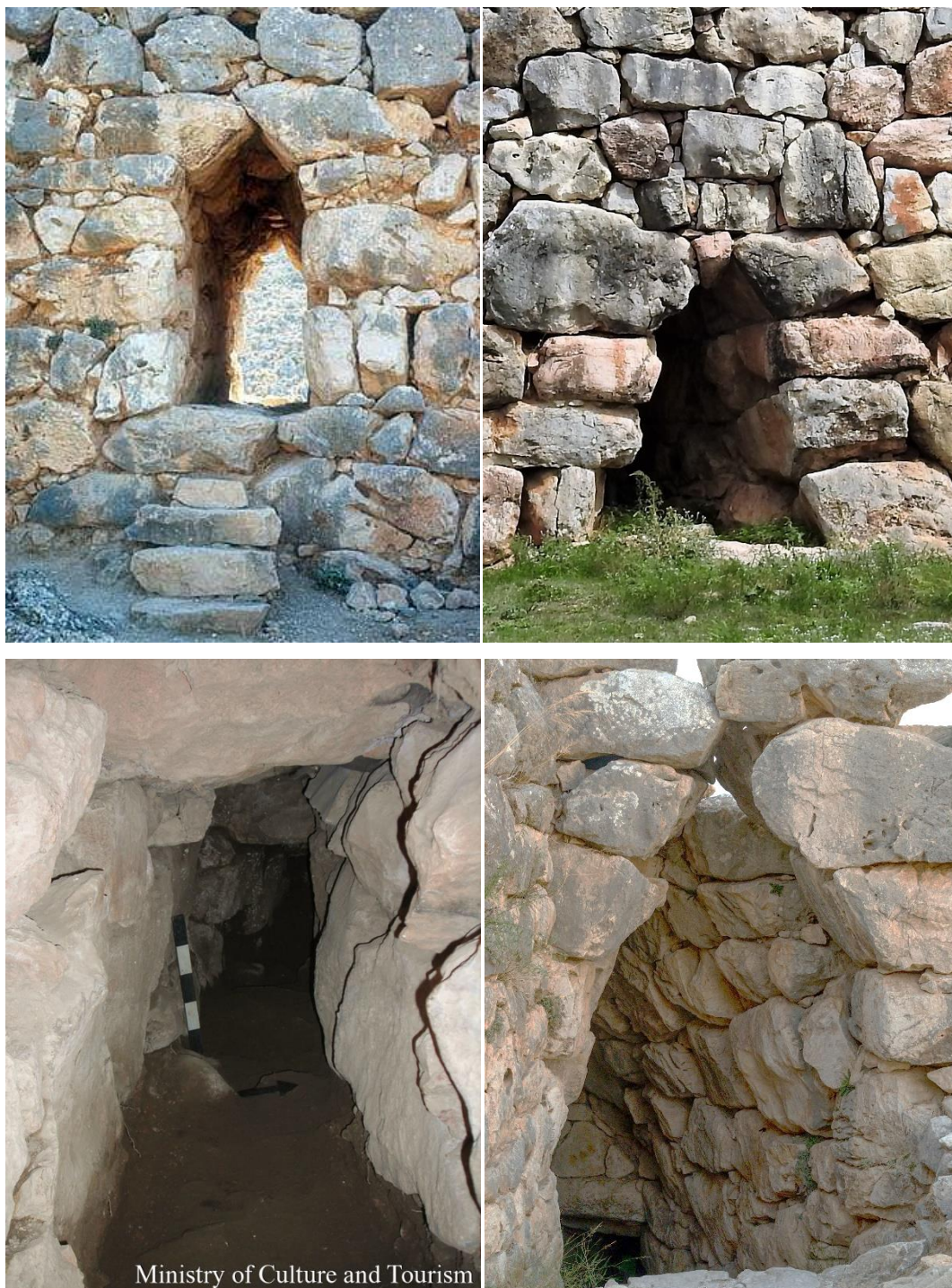
Figura 4 – Tipos de arcos corbelados micênicos 42
