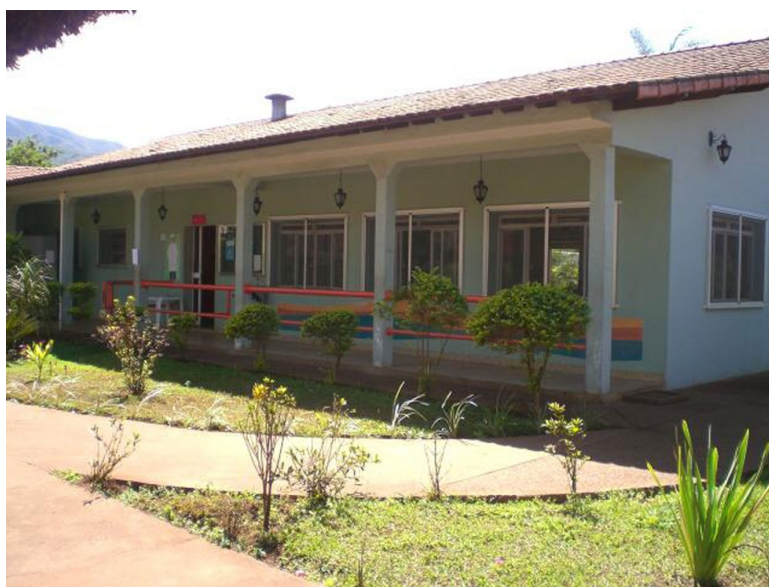
Figura 55 - Vista do refeitório na mina do Córrego do Feijão em 2008
