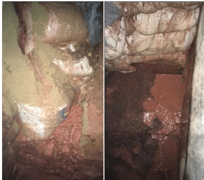
Figura 123 - Vista de sacarias de areia sobre a escada de drenagem da barragem B I em 12/06/2018
