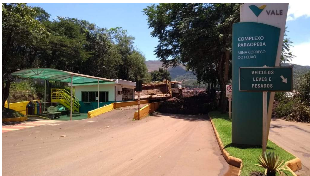
Figura 57 - Portaria da mina Córrego do Feijão tomada pela lama
