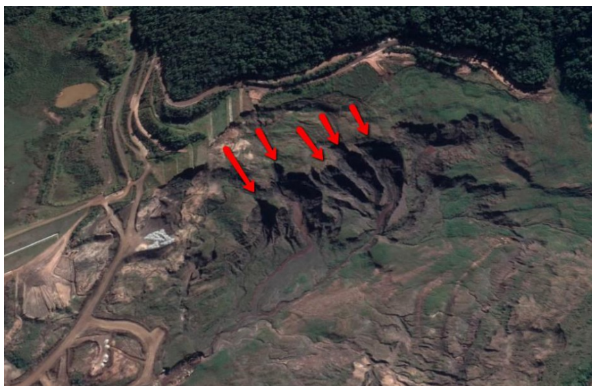
Figura 44 - Localização das nascentes exsurgentes após o rompimento da B I
