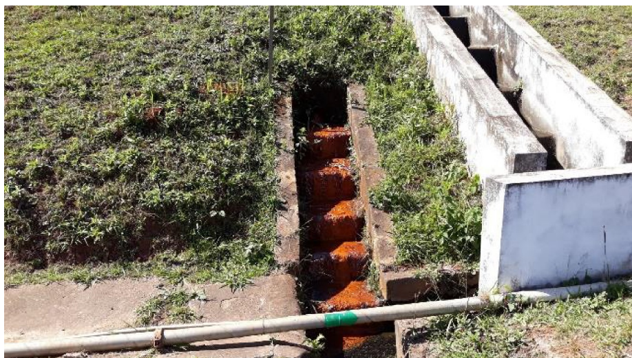
Figura 78 - Saída de drenagem interna na barragem B I com colóide
