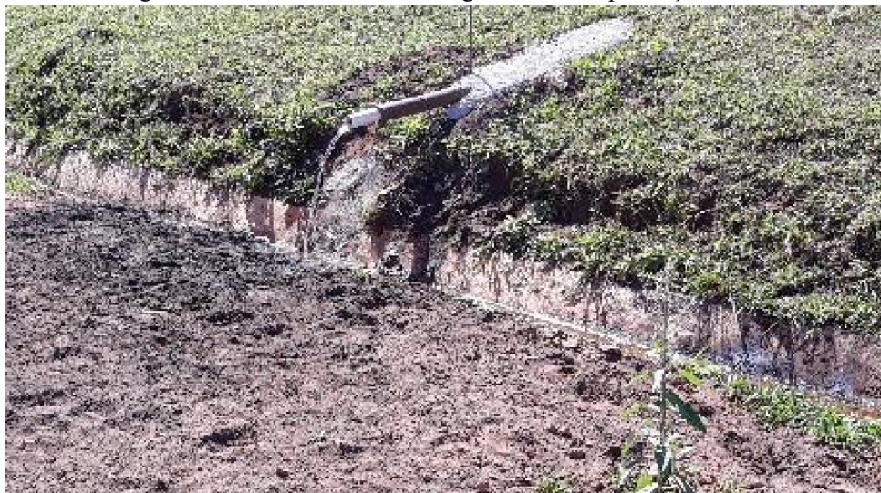
Figura 79 - DHP instalado na barragem B I sem a presença de sifão
