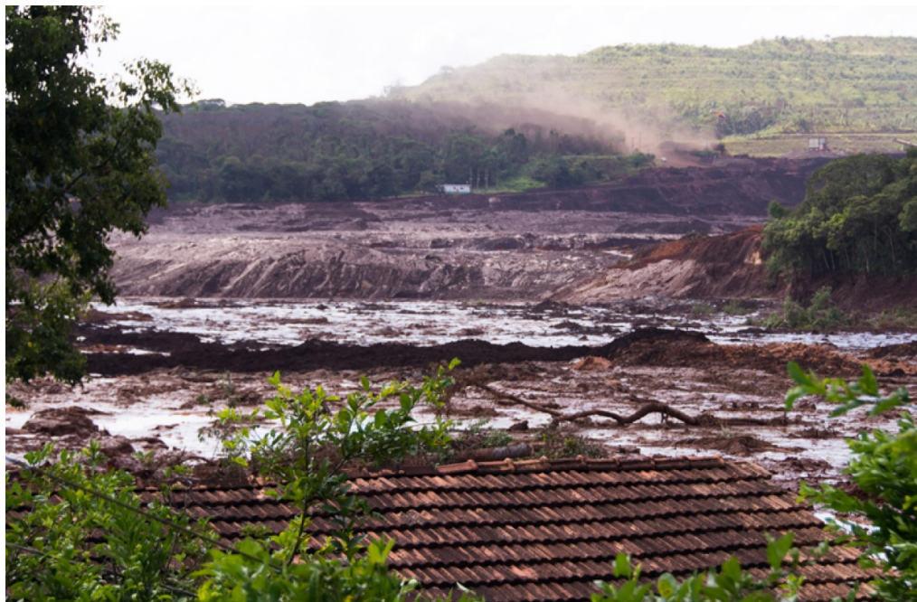
Figura 58 - Casa destruída pela lama bem próxima à mina Córrego do Feijão
