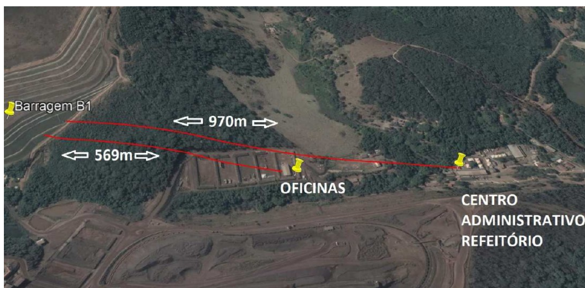
Figura 51 - Distâncias entre o pé da barragem B I e instalações da mina Córrego do Feijão
