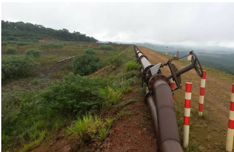
Figura 86 - Arbustos no talude de montante e dentro do reservatório da barragem B I
