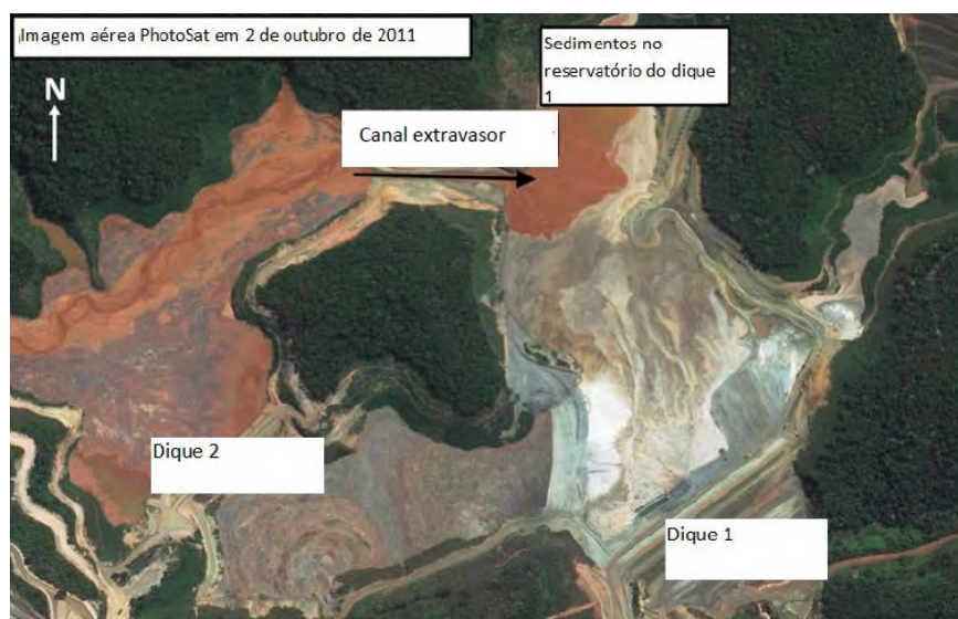
Figura 112 - Canal extravasor de lama que foi aberto entre o reservatório dos Diques 1 e 2 em meados de 2011
