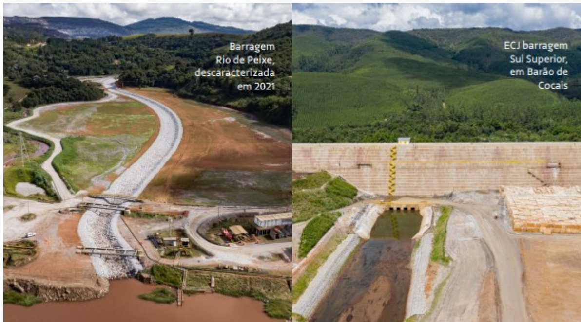
Figura 101 - Barragem Rio de Peixe já descaracterizada e a Estrutura de Contenção a Jusante (ECJ) das barragens Sul Superior e Sul Inferior em Barão de Cocais/MG
