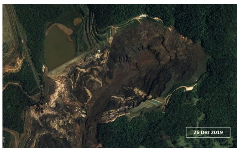
Figura 22 - Visão superior da barragem B I após seu rompimento
