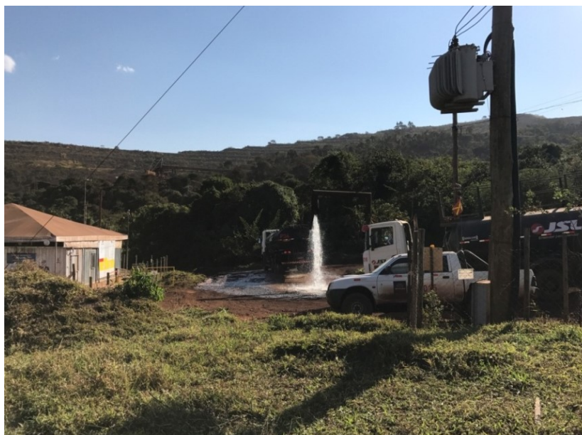
Figura 131 - Instalações junto ao pé da barragem B I que precisariam ser removidas
