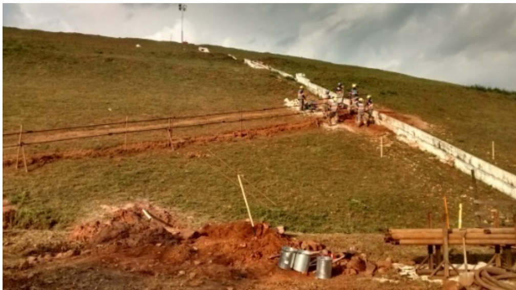
Figura 121 - Execução de dreno invertido e reparo de escada de drenagem na barragem B I
