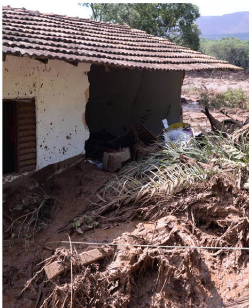
Figura 29 - Casa destruída no povoado Córrego do Feijão
