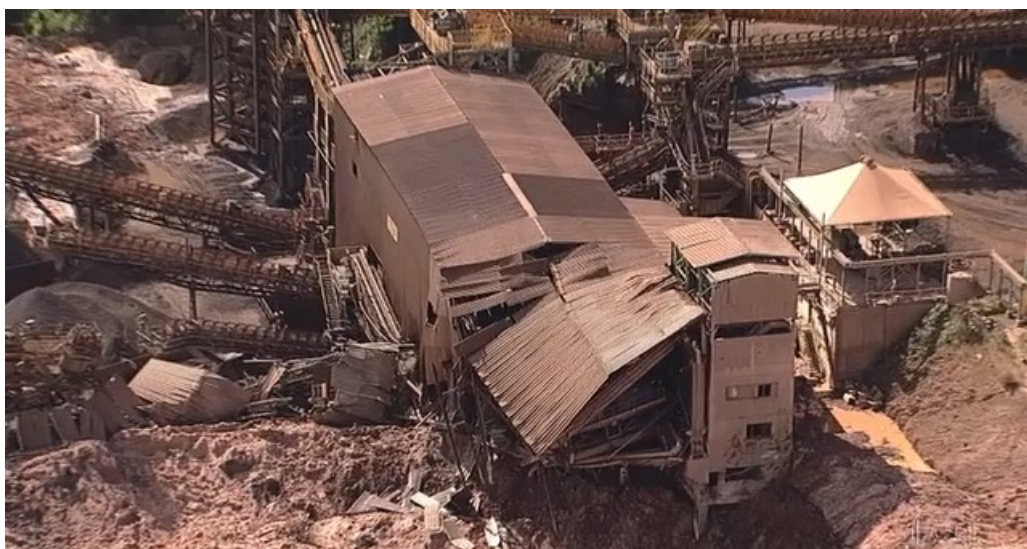
Figura 56 - Instalação de tratamento de minérios da mina Córrego do Feijão destruída
