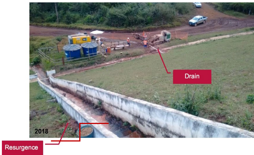
Figura 120 - Execução do 15º DHP que resultou em fratura hidráulica do dique inicial
