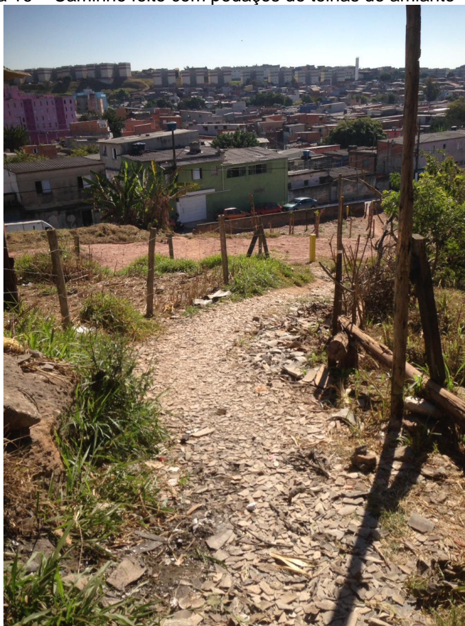
Figura 16 – Caminho feito com pedaços de telhas de amianto
