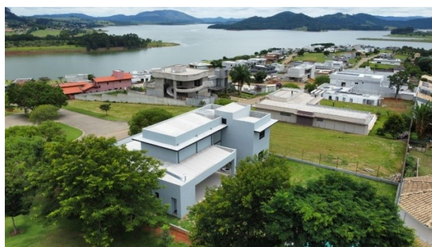
Foto 54: Urbano Margem Represa - Drone
