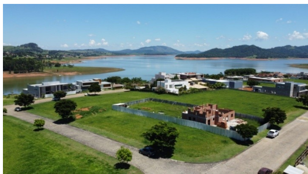
Foto 47: Urbano Margem Represa - Drone
