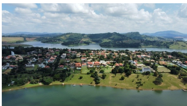
Foto 49: Urbano Margem Represa - Drone
