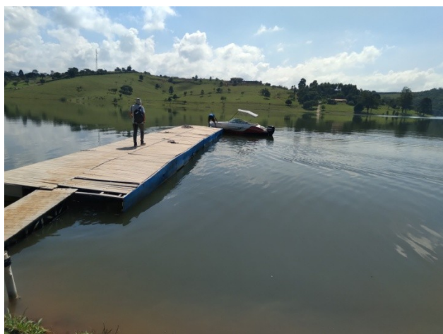
Foto 57: Pier Margem Represa
