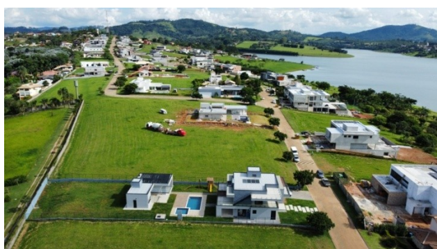
Foto 43: Urbano Margem Represa - Drone
