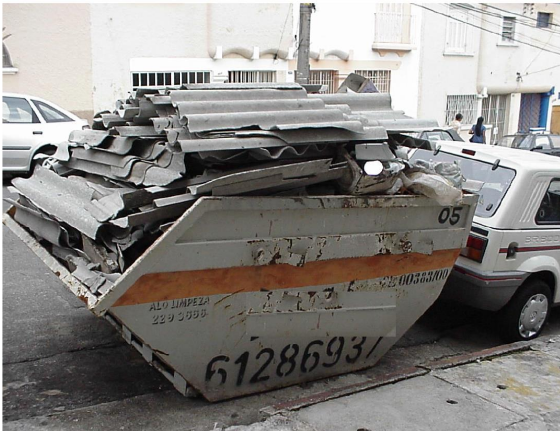
Figura 5 - Uso indevido de caçamba de entulho no transporte de RCC perigosos
