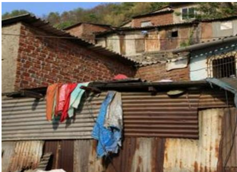
Figura 39 - Uso de TCA com a função de divisórias em moradias de baixa renda
