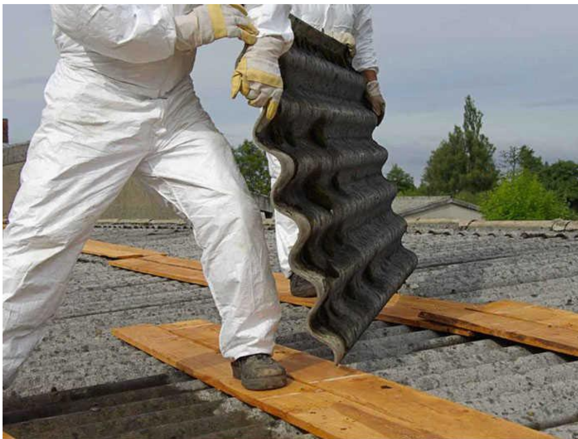
Figura 2 - Retirada de telhas de cimento-amianto com uso de EPI
