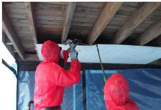
b- Placas de isolamento com amianto
