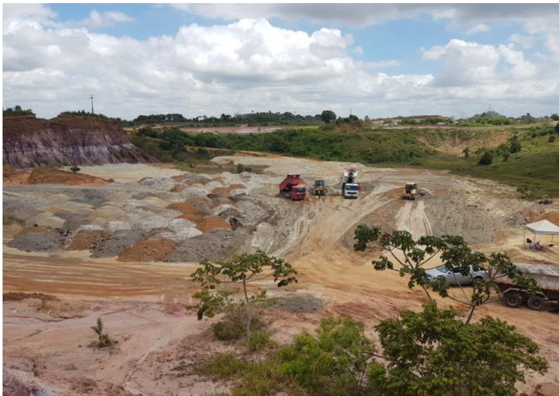
Figura 7 - Aterro de resíduos da construção civil classe A
