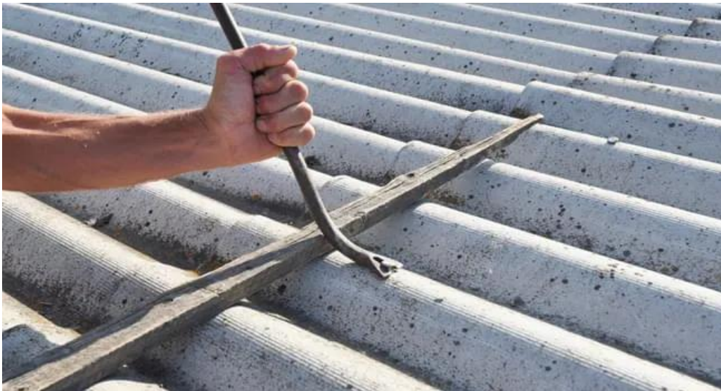
Figura 50 - Retirada de prego de fixação diretamente sobre a TCA
