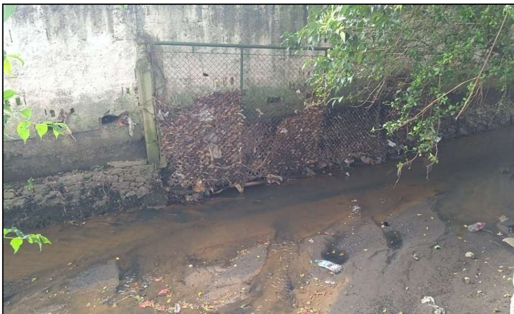
Figura 56: Grade instalada em trecho do córrego Tenente Rocha. Fonte: Elaboração do autor, 2019.
