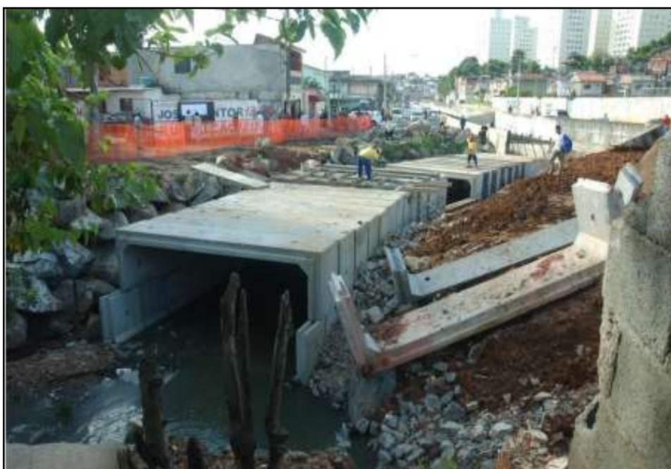
Figura 8: Obra do PROCAV na canalização do córrego rio das Pedras, Zona Sul de São Paulo. Fonte: CARDOSO, 2015 (FAU USP).
