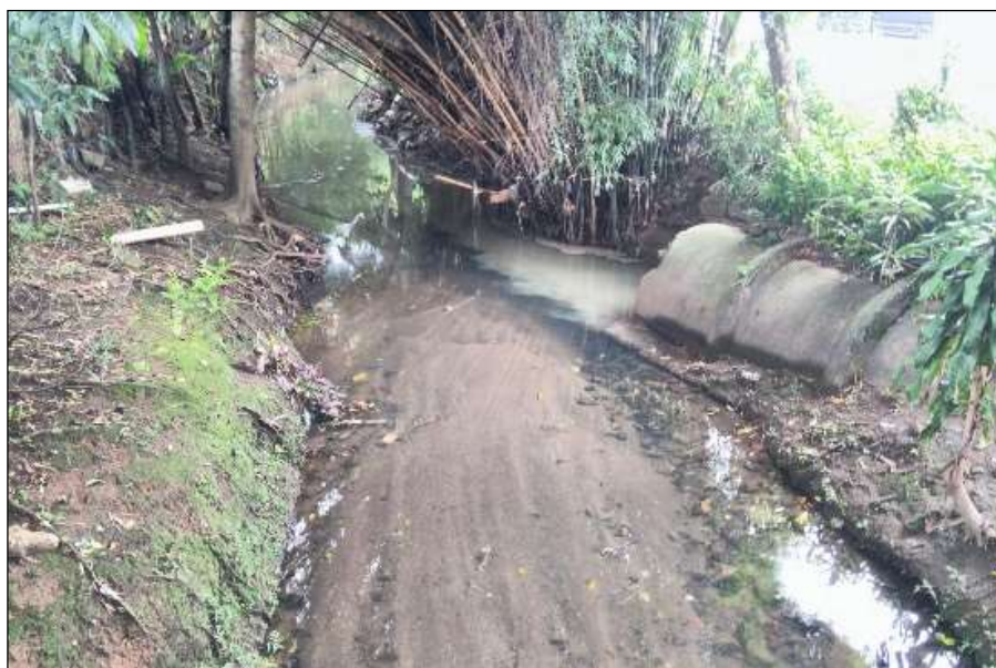
Figura 32: Lançamento esgoto em trecho do córrego Tenente Rocha. Fonte: Elaboração do autor (2020).
