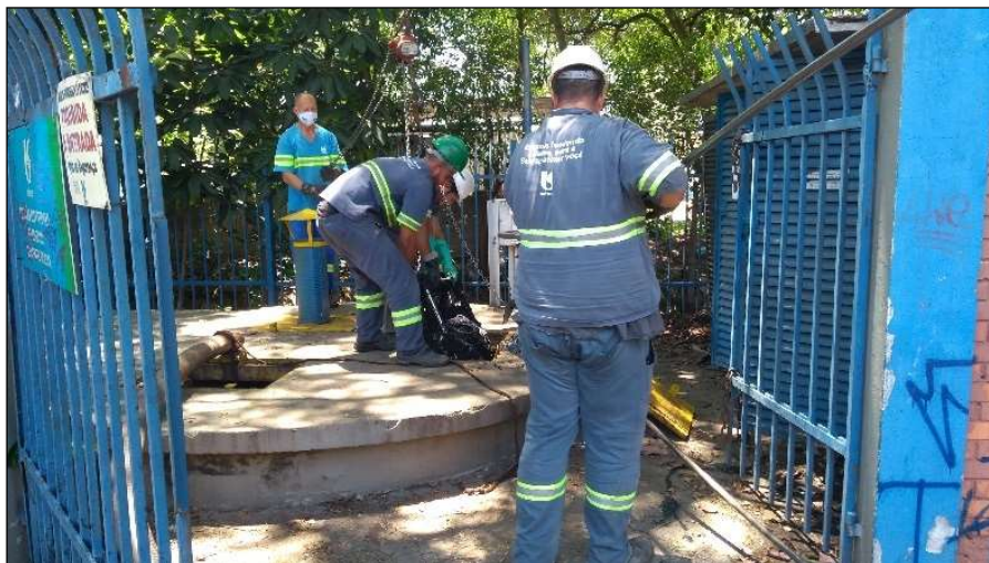
Figura 63: Manutenção regular da Estação Elevatória de Esgotos do córrego Tenente Rocha. Fonte: Elaboração do autor, 2020.
