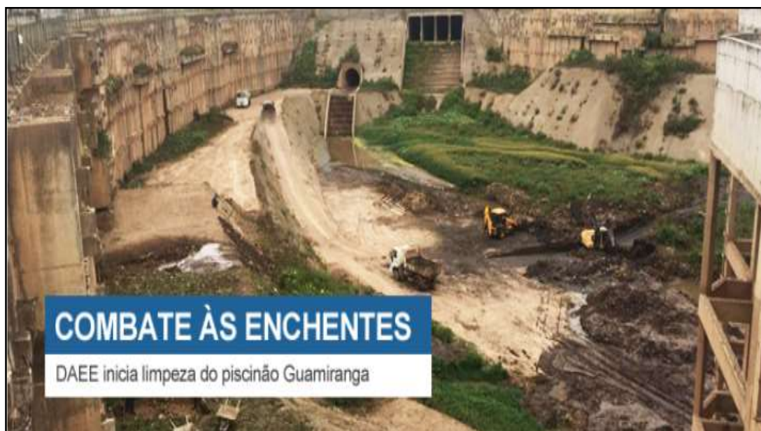
Figura 13: Limpeza do piscinão de Guamiranga, bairro de Vila Prudente, na capital paulista. Fonte: Departamento de Águas e Energia Elétrica (DAEE). Disponível em: < http://www.daee.sp.gov.br/index.php >.
