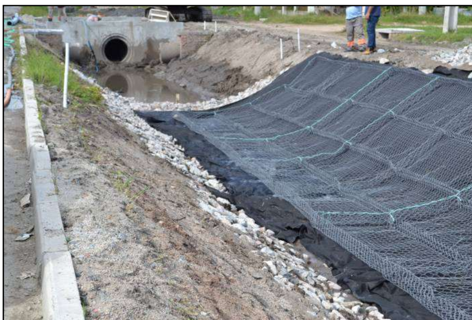
Figura 11: Emprego de tratamento de fundo de canal tipo colchão na cidade de Pelotas, Rio Grande do Sul. Fonte: Adaptado do site da Prefeitura Municipal de Pelotas. Disponível em: < https://www.pelotas.rs.gov.br/noticia/canal-da-espírito-santo-recebe-tecnica-de-colchao-reno >.
