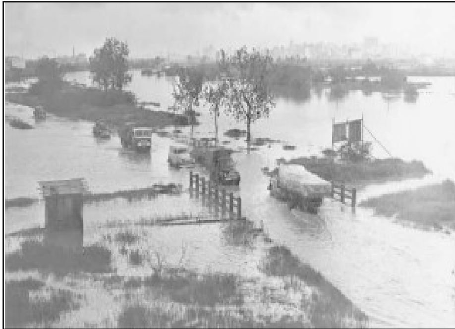
Figura 4: Trecho do rio Tietê, após obras de retificação no início dos anos 1900.
