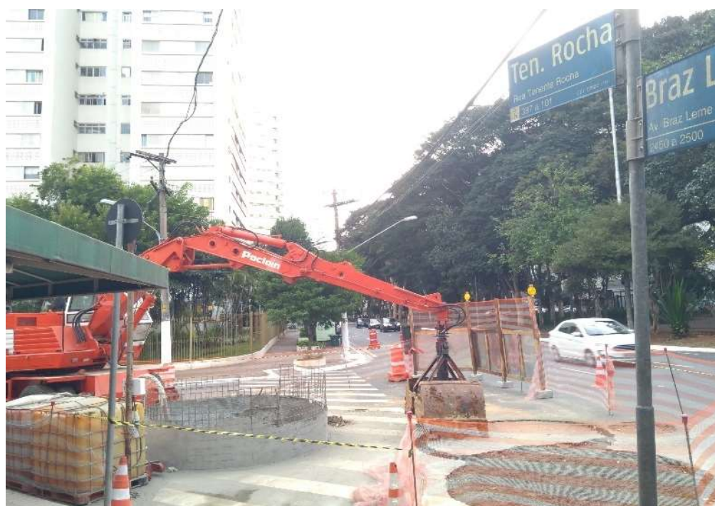
Figura 66: Obras do Interceptor Tietê ITI-2 no início da rua Tenente Rocha. Fonte: Elaboração do autor, 2020.
