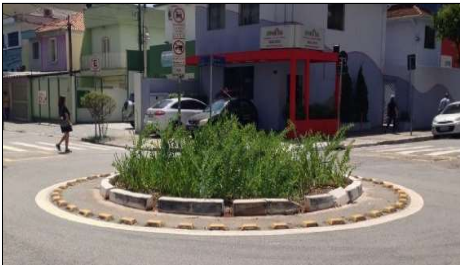
Figura 16: Jardim de chuva construído em rotatória do bairro Tatuapé, São Paulo. Fonte: adaptado de: < http://conexaotatuape.com.br/2019/01/29/jardim-de-chuva-como-melhorar-a-relacao-da-cidade-com-a-agua-da-chuva/ >.
