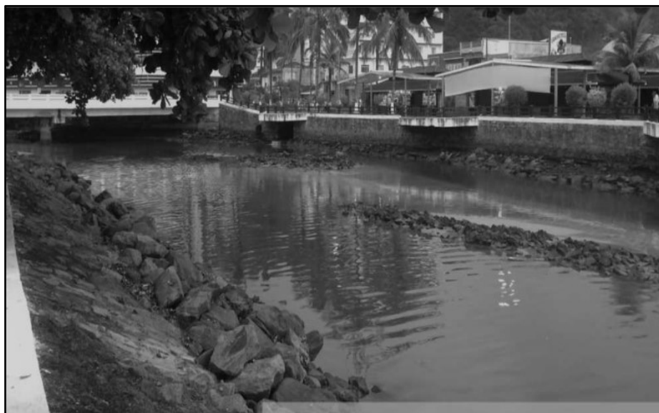
Figura 10: Emprego de tratamento de fundo de canal tipo enrocamento no rio Mongaguá, município de Mongaguá, São Paulo. Fonte: Adaptado de SILVA, 2017.
