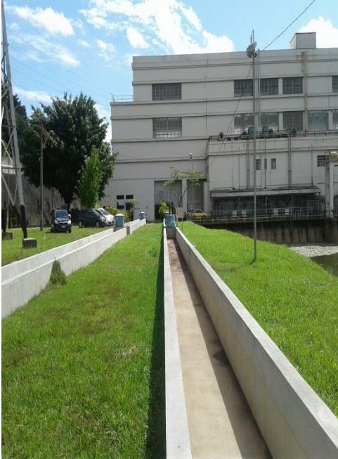
Figura 14 - Canal instalado na UET
