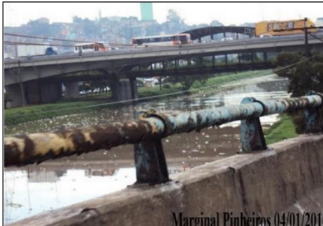
Figura 3 - Estrutura metálica do rio Pinheiros
