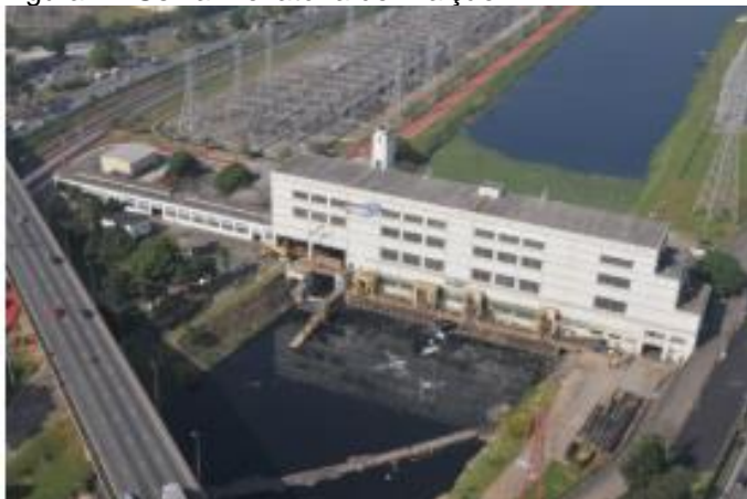
Figura 2 - Usina Elevatória de Traição
