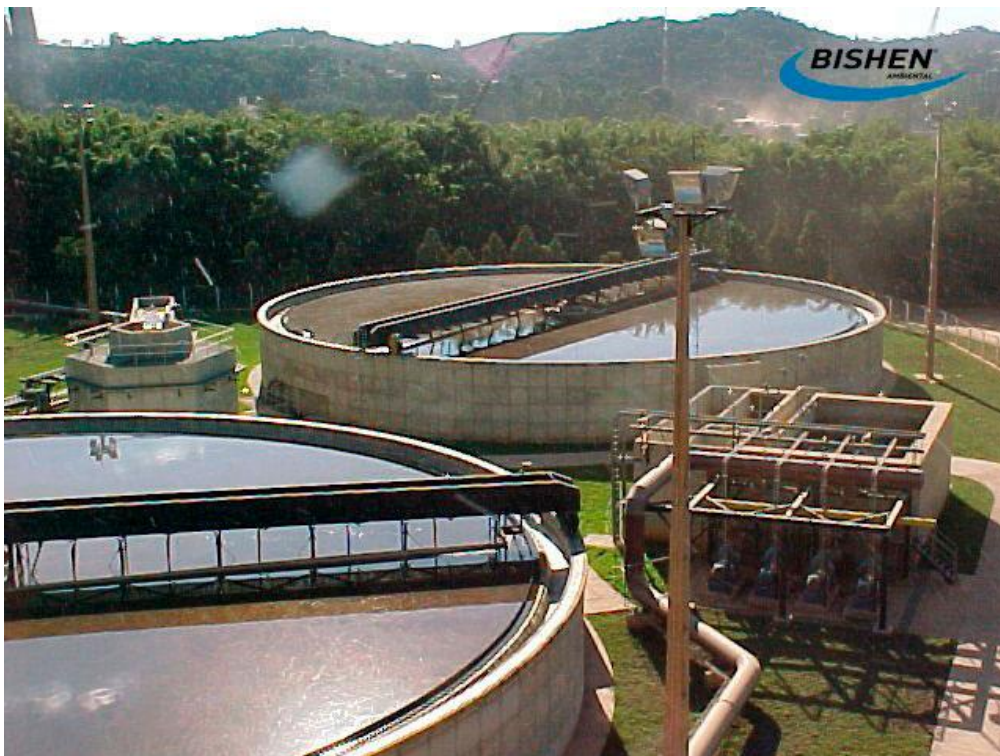
Figura 14. Exemplo de decantador primário
