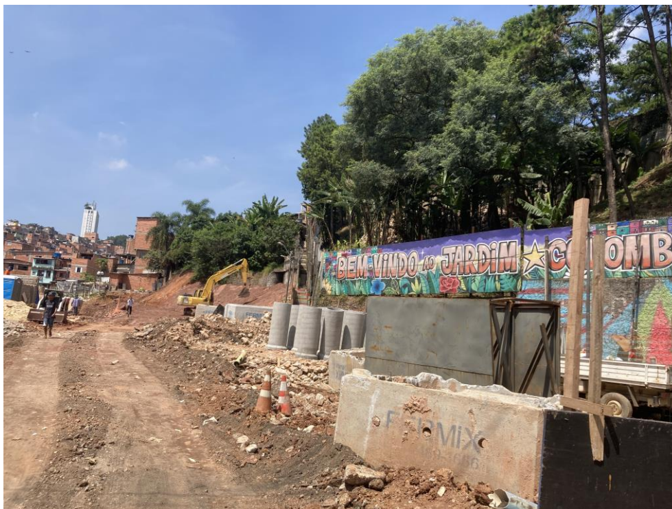
Figura 18: Obra de canalização do córrego do Jardim Colombo.: Fonte: Nilton Stanguini.
