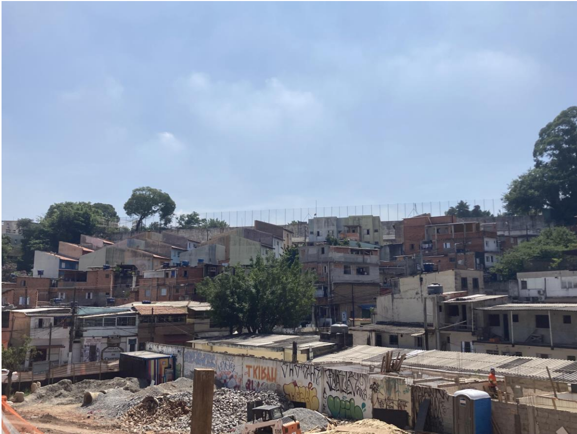
Figura 28: Muro e grade na divisa entre uma escola e o Jardim Colombo. Fonte: Nilton Stanguini.
