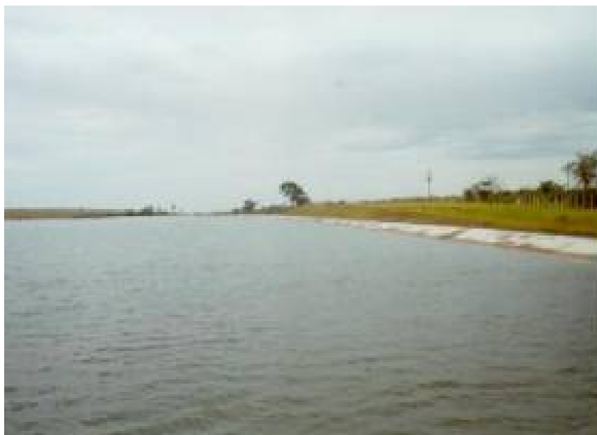
Figura 4: Vista panorâmica da Lagoa Facultativa
