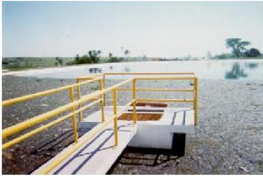
Figura 3: Vista parcial da Lagoa Anaeróbia
