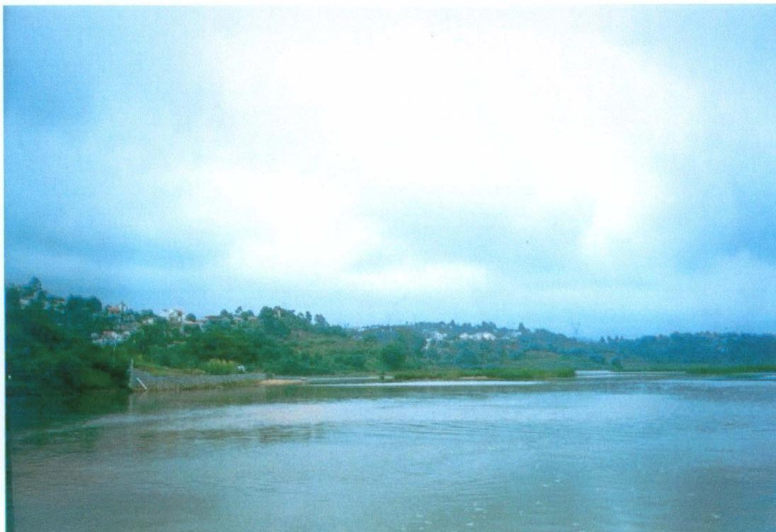
**Foto 11.** RESERVATÓRIO PAIVA CASTRO, 2001 – TRECHO DE CAPTAÇÃO DE ÁGUA DO MUNICÍPIO PORÇÃO BASTANTE ASSOREADA PPRÓXIMA À RODOVIA FERNÃO DIAS. AO FUNDO É POSSÍVEL VISUALIZAR VÁRIAS ILHAS QUE NÃO EXISTIAM ATÉ 1999
