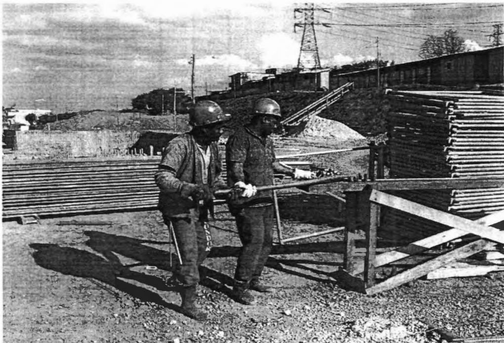
Foto: Operários preparam cadeira Chaise Longue. Utilização da dobradeira improvisada no meio do canteiro. Mesmo ferramental e mesmo material utilizado na construção do edifício.
