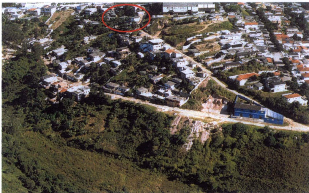
Figura 37. Vista geral do entorno da favela. No topo localiza-se a indústria metalúrgica Italforja (apud CDHU 1996a).
