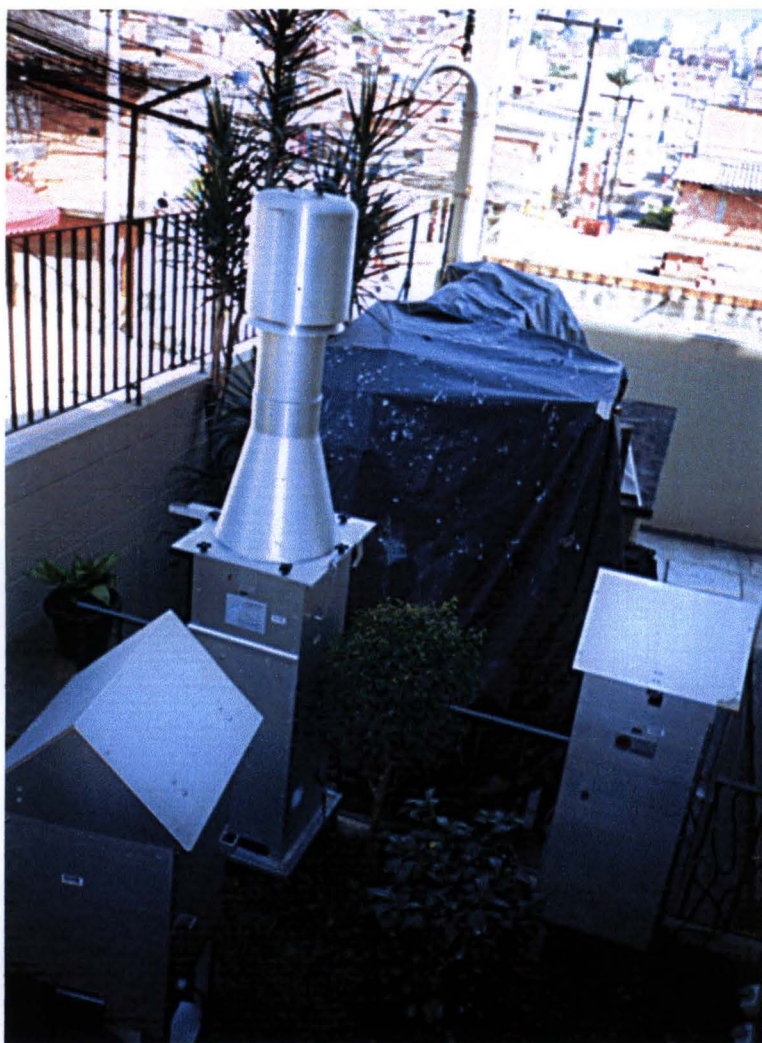
Figura 9 - Amostradores de poluentes PTS, PI e NO 2 - Creche Centro Comunitário
