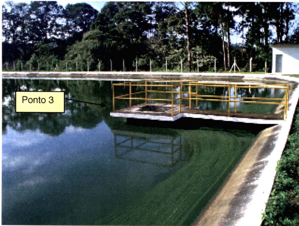
Figura 6.16 Ponto de coleta n° 3 (saída da lagoa facultativa).
