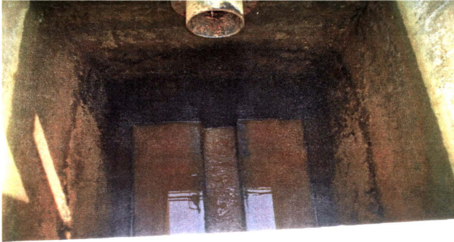
Figura 6.10 Limpeza dos filtros.
