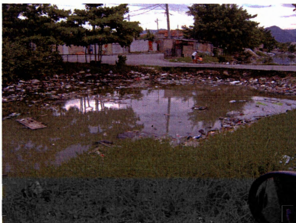
Dique das Caxetas – Bairro Jóquei Clube
