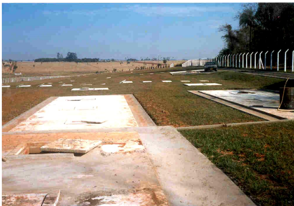
Figura 8 - Infiltração de efluentes de fossa-filtro – Queirós, SP, Brasil.
