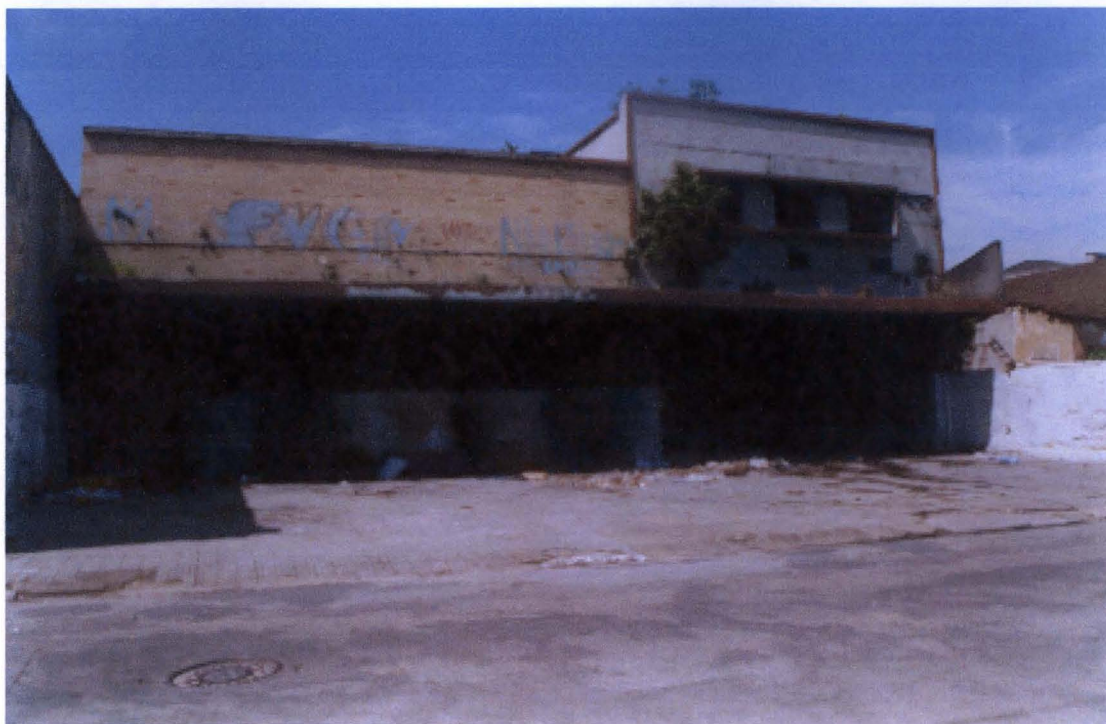
Figura 12 – Edificação abandonada com disposições irregulares de RCD, Santos, SP.
