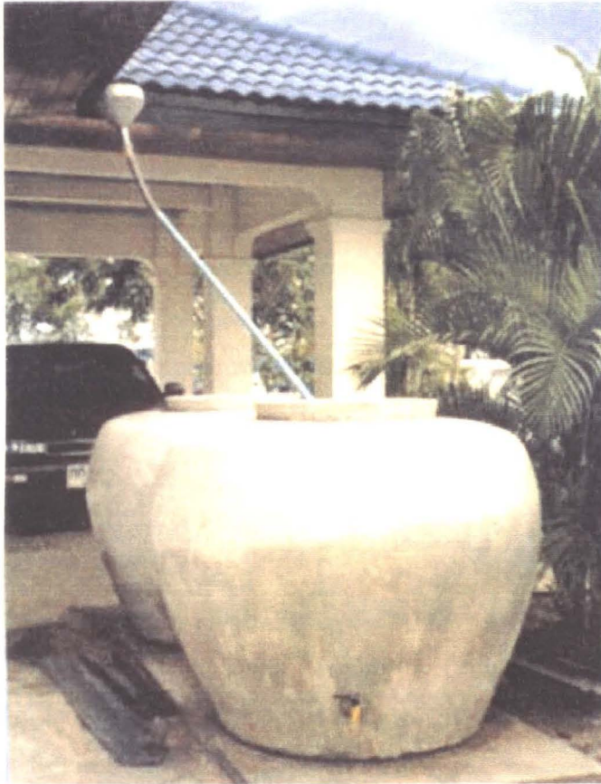
Figura 4.6.1.2: Duto de alimentação e torneira para utilização das águas. Fonte: www.ircsa.org/images/thaitankbig.jpg
