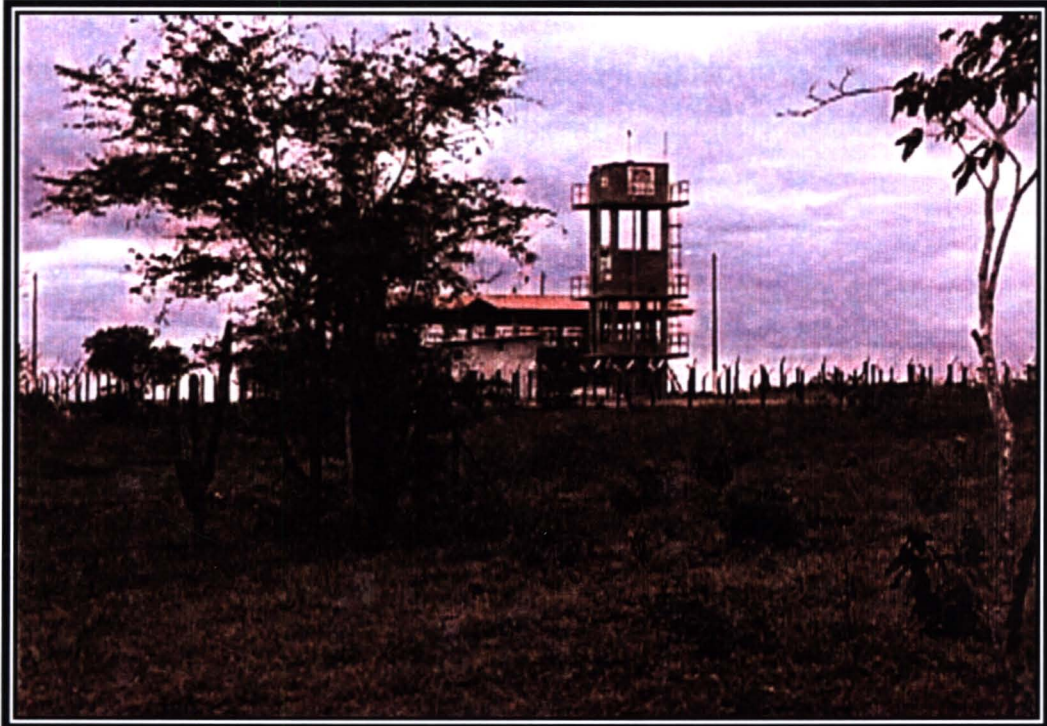
Figura 11 Estação de Tratamento de Água com Filtro Lento para Piaus e Taquari.
