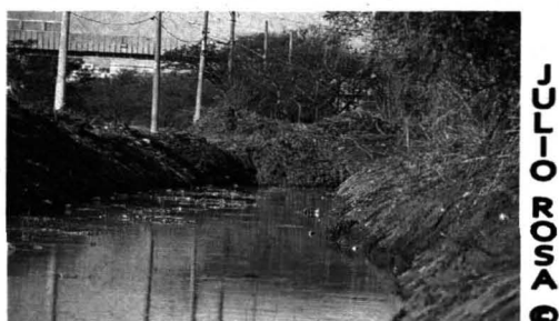
E. Canal de Circunvalação, denominado Rio "Negrinho", Próximo à EE. Irmã Annete.
