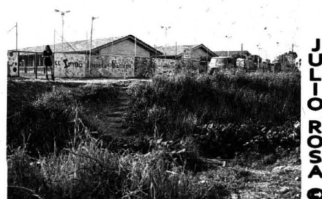
D. Esgoto degradado em frente à EE. Irmã Annete.
