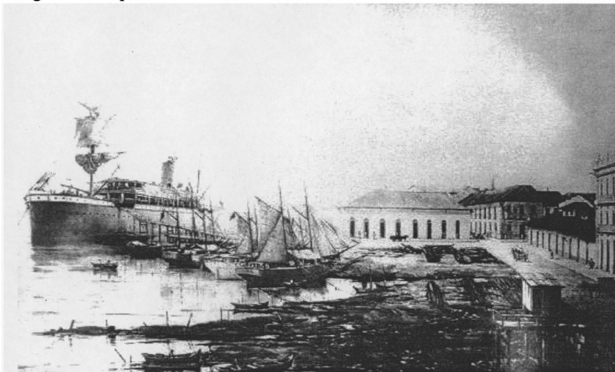
Figura 04: As pontes de madeira se estendem a 100 metros do cais. 1870.
