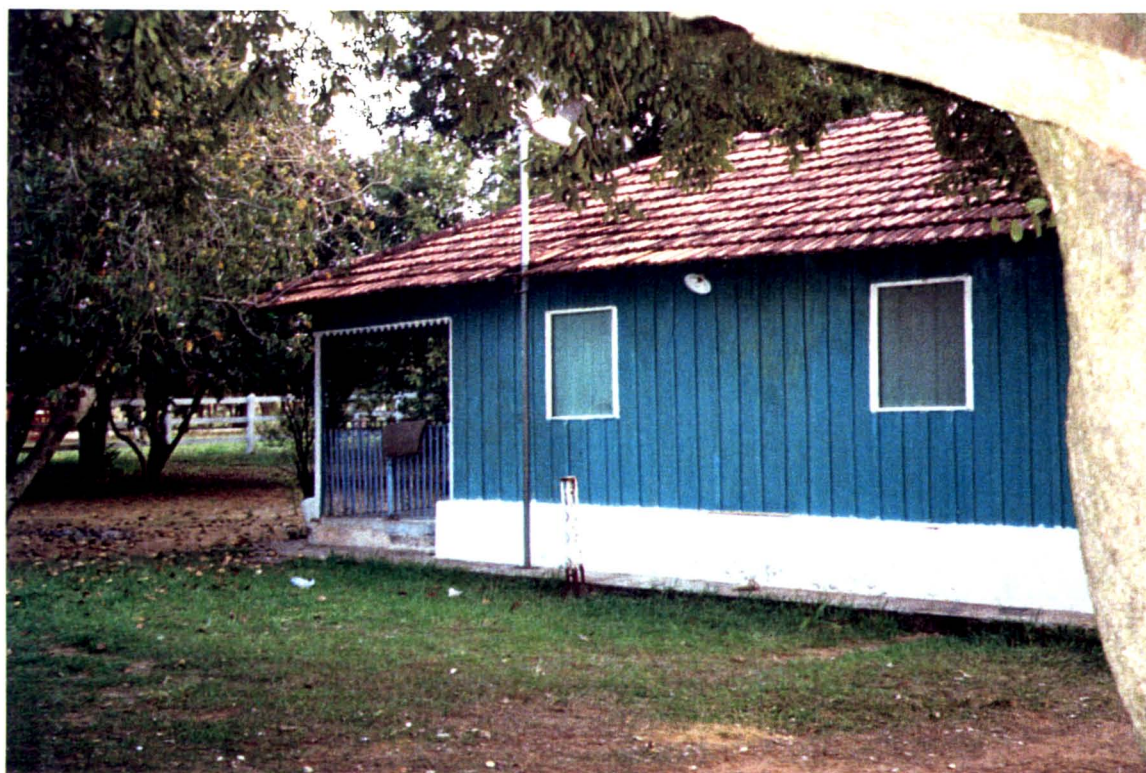
Figura 6 – Idem. Face norte da casa. Notam-se as janelas teladas para proteger o interior do domicílio contra o ingresso de insetos.
