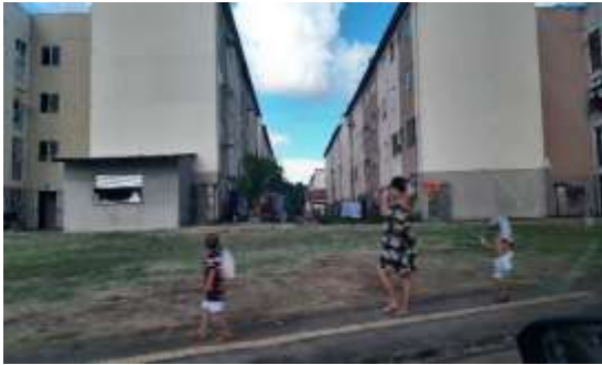
Figura 15 - Construção anexa a estrutura dos apartamentos
