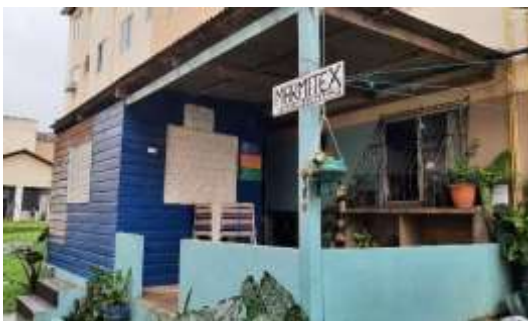
Figura 13 - Construção de espaço destinado a venda de alimentos
