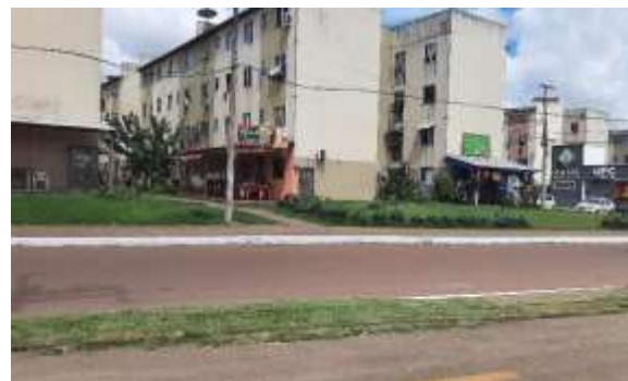
Figura 14 - Mudanças na estrutura do prédio para atividades econômicas
