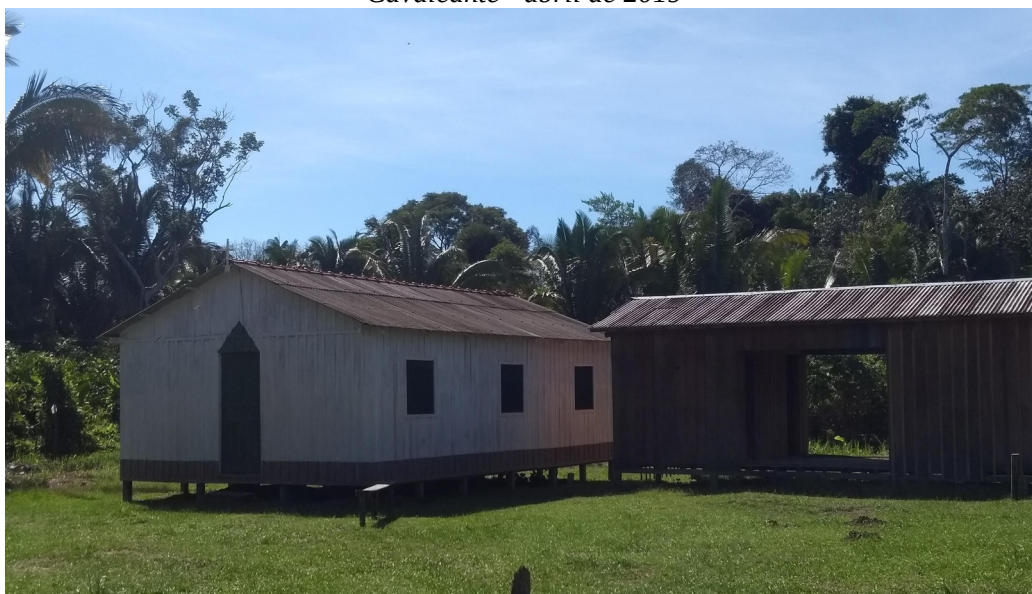
Figura 13: Igreja católica e Posto de Saúde (em construção) na comunidade de Cavalcante - abril de 2019
