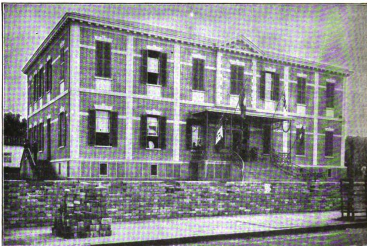
Figura 34 – Novo prédio do Collegio Methodista em Ribeirão Preto
