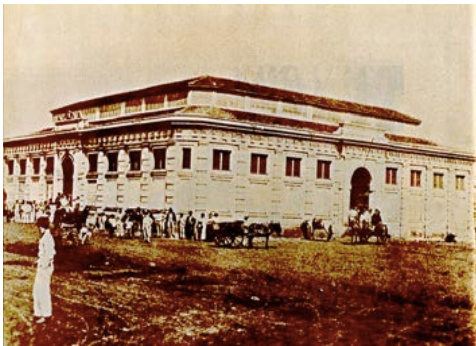
Figura 63 - O Mercado Municipal de Ribeirão Preto, construído em 1902
