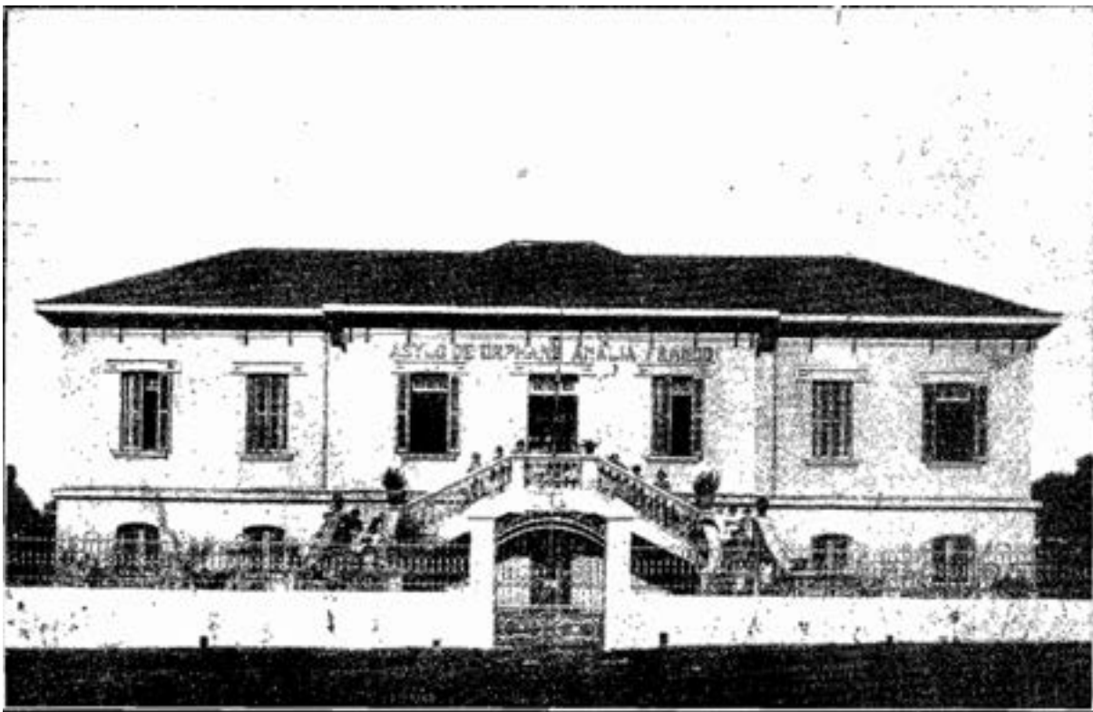
Figuras 145 e 146 – Fachada principal e vista geral do Asylo Anália Franca, 1925
