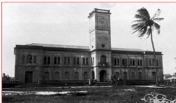
Figura 63 - Estação Natal da Estrada de Ferro do Rio Grande do Norte na década de 1930
