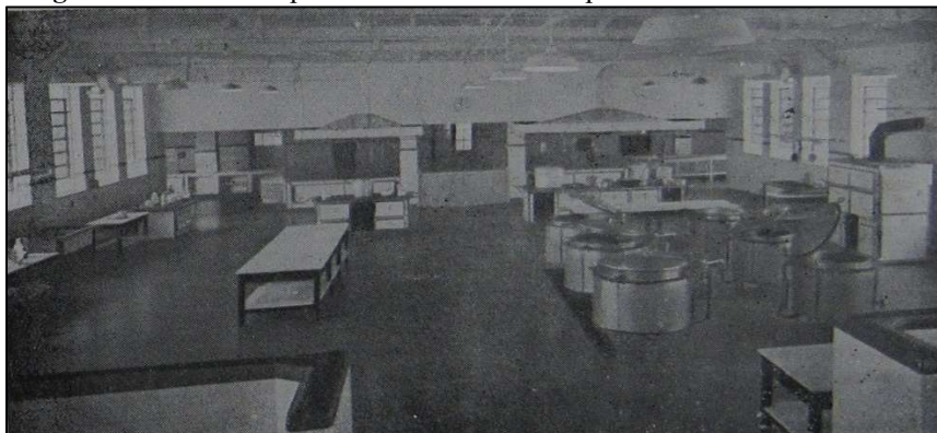
Figura 116 - Vista ampliada da cozinha do Hospital da Santa Casa de Santos
