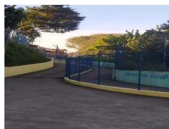
Rampa de acesso
