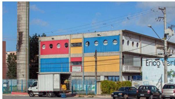
Figura 40: Faixada de escola.
