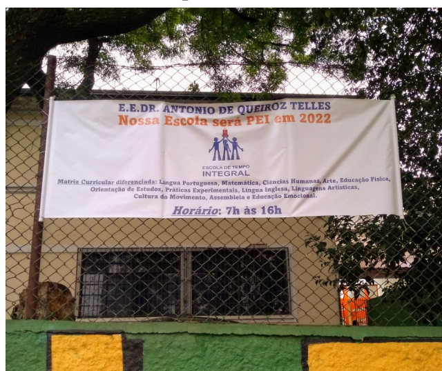
Figura 23 – Fachada de escola candidata ao PEI na cidade de São Paulo, zona leste da capital, 2021 59
