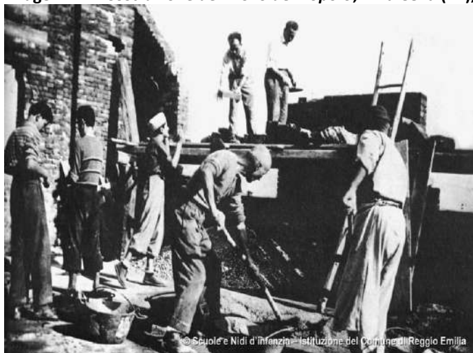
Imagem 17 – Costruzione dell’Asilo del Popolo, Villa Cella (RE), 1946.
