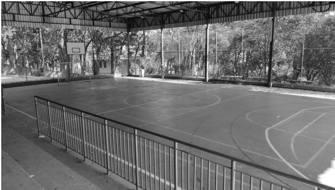
Figura 9 – Quadra externa da EMEF
