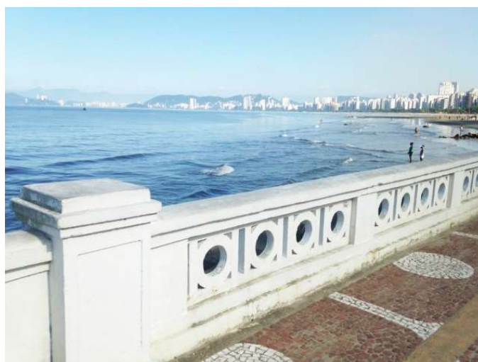
Figura 3 – Mureta dos canais de Santos (SP)
