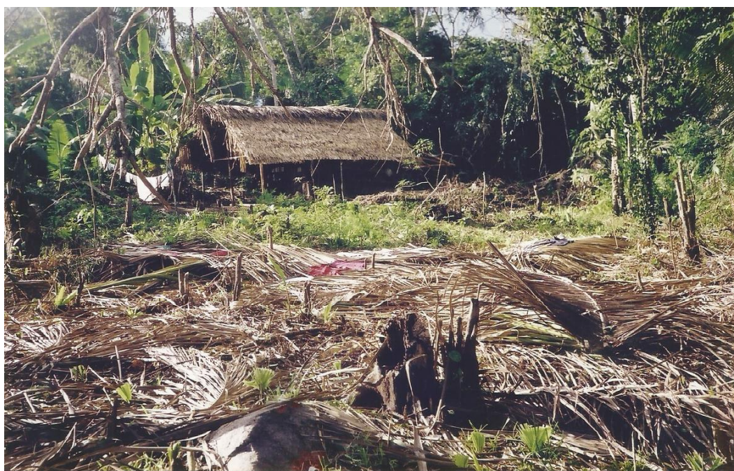
Figura 25 - Escolha e Limpeza do Terreno para construção da Escola
