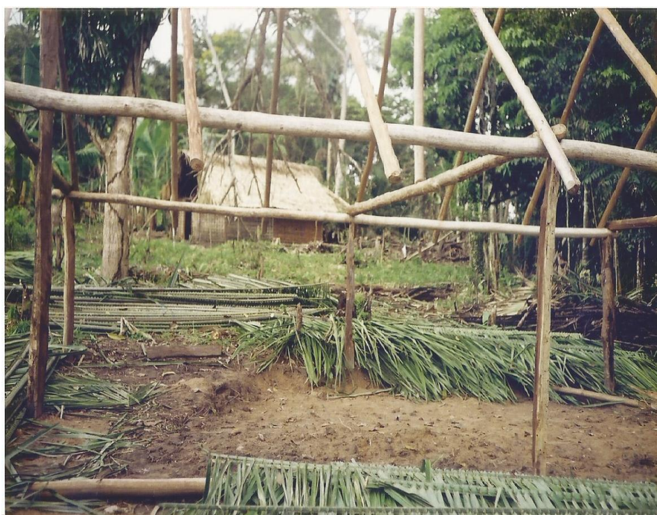
Figura 26 - Os elementos-base que foram utilizados para a construção da escola
