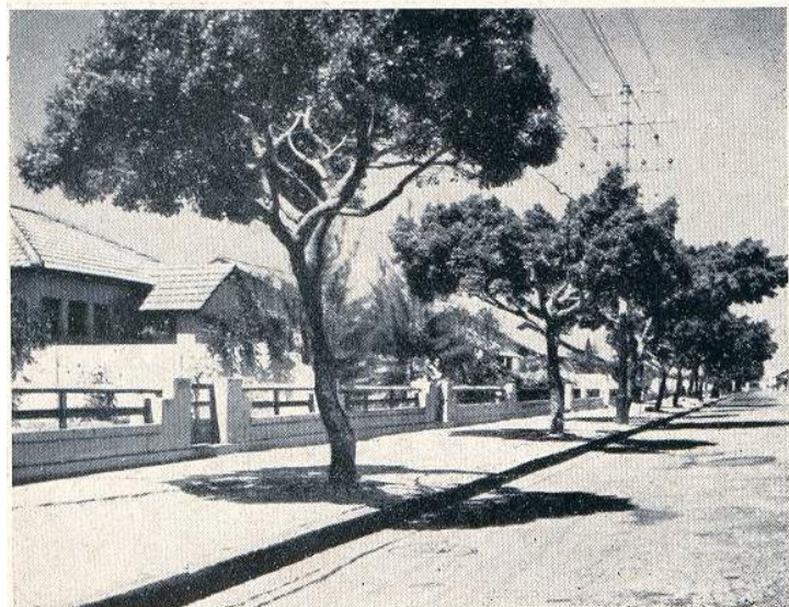
Vila dos Funcionarios e Operarios das Docas do Porto. (Cabanga)
