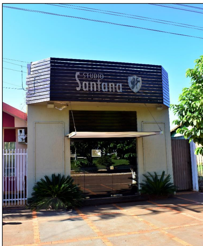
Figura 119 – Fachada atual do Studio Santana. 2022.
