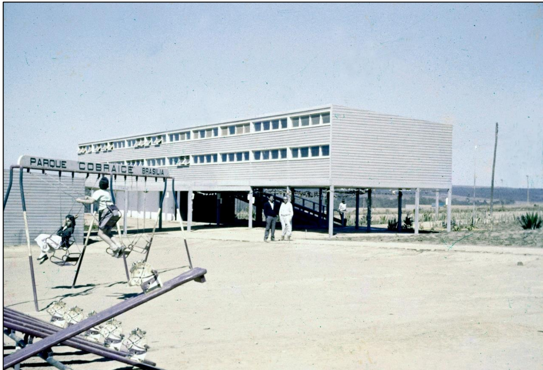
Figura 30 – Escola Júlia Kubitschek com elementos da área externa ao edifício escolar
