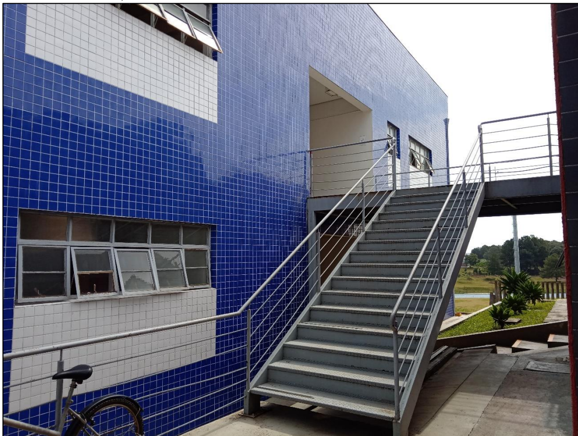
Foto 15: Área externa, vista das escadas de acesso às salas de aulas.
