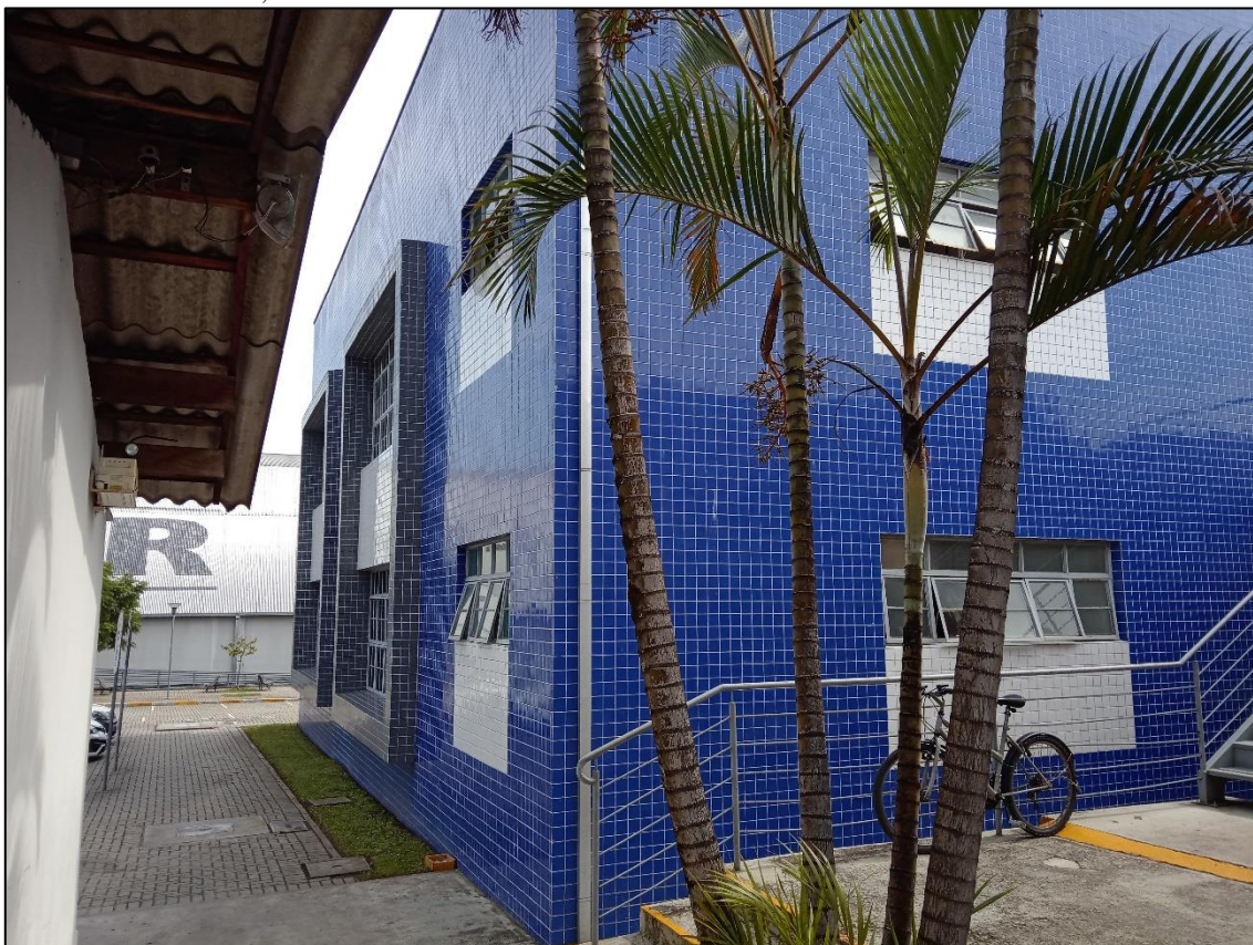
Foto 14: Área externa, vista lateral de acesso à escada.
