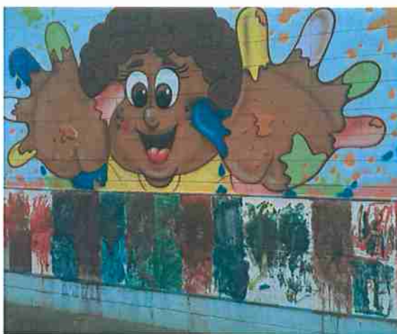
Foto 48. Parede de azulejo.
