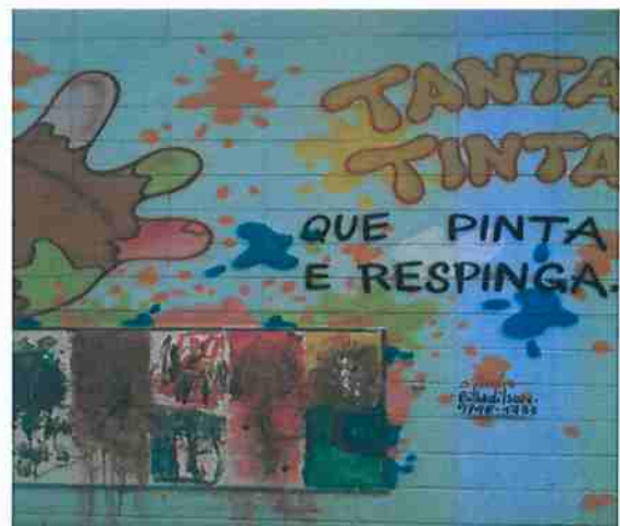
Foto 49. Parede de azulejo.
