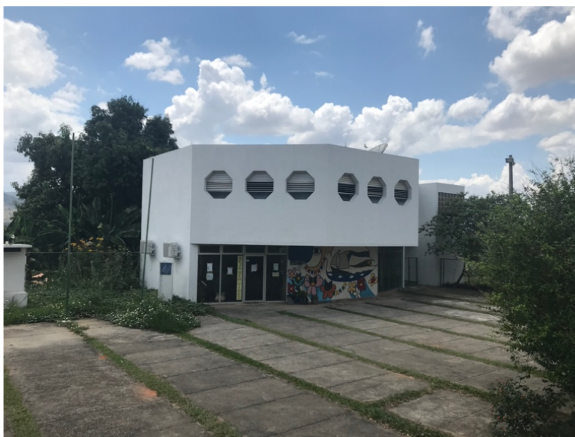
Figura 1 - Biblioteca área externa
