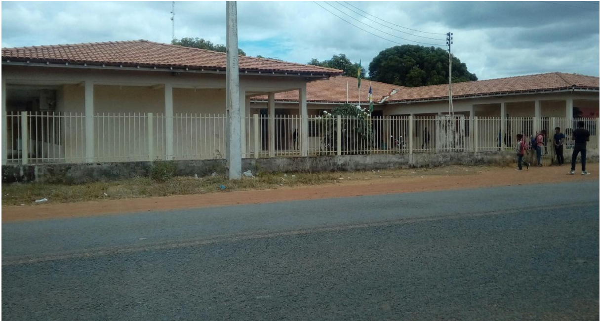
Figura 8 – Fachada da Escola Estadual Indígena Santa Luzia
