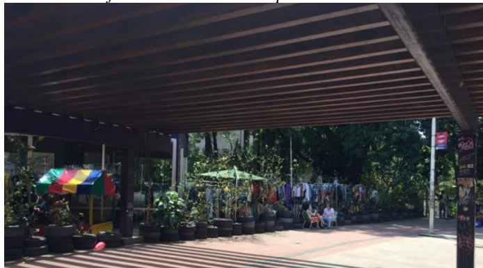
Figura 6: Vista lateral café Via Roosevelt e rampa de acesso à Rua da Consolação
