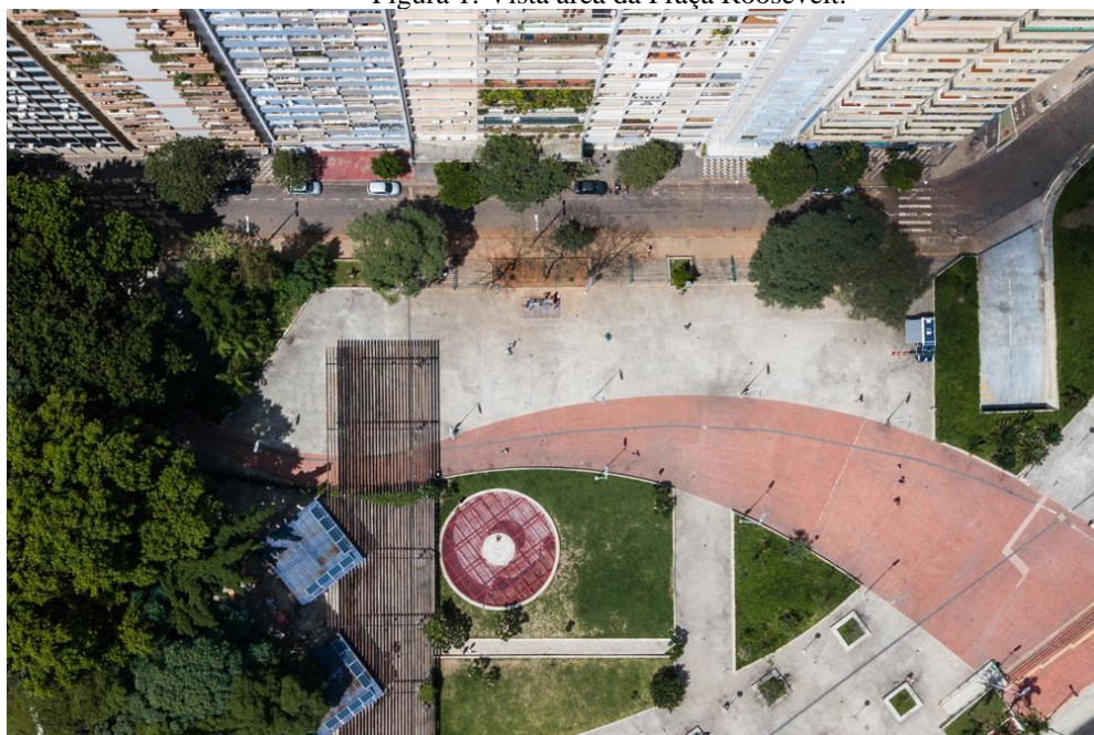
Figura 1: Vista aérea da Praça Roosevelt.
