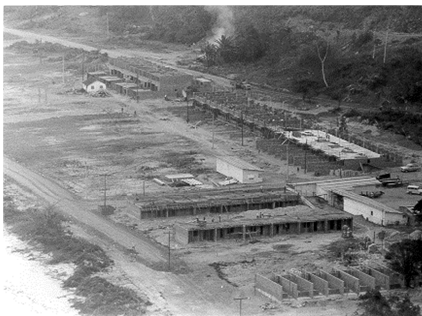
Imagem 46 – Construção da Vila Residencial de Praia Brava – Década de 1970 Fonte: arquivo Eletronuclear (retornar para a página 87)
