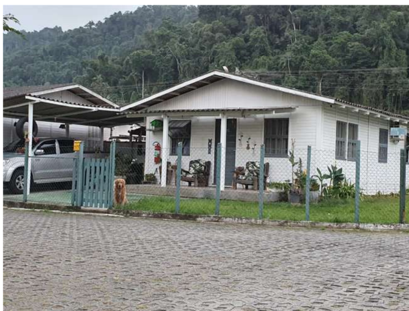
Imagem 43 – Tipo de residência E-3 – madeira com três quartos, térrea Vila Andrade Gutierrez (Consag).
