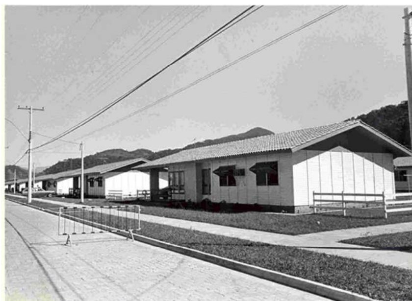
Imagem 24 – Vila Residencial de Mambucaba: as primeiras casas de madeira Fonte: arquivo Eletronuclear (retornar para a página 86)
