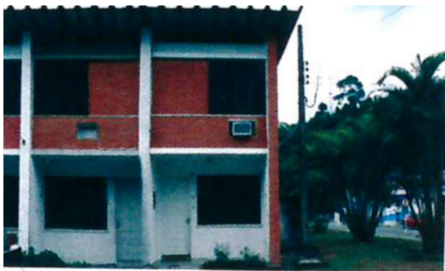
Imagem 37 – Tipo de residência D-2 – alvenaria com dois quartos e dois pavimentos Vila Residencial de Praia Brava.
