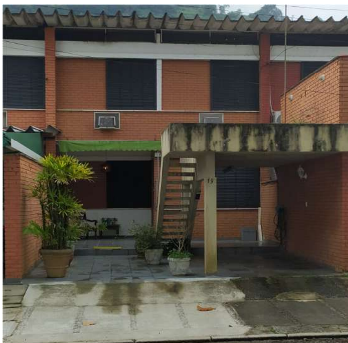
Imagem 40 – Tipo de residência B-3 – alvenaria com três quartos, quarto de empregada, dois pavimentos e com garagem Vila Residencial de Praia Brava. Fonte: arquivo pessoal
