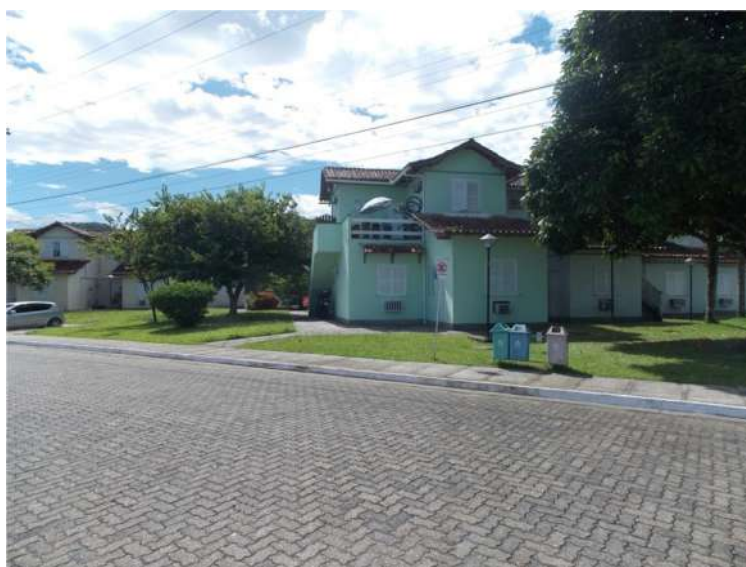
Imagem 32 – Flats – pavimento térreo e superior, cozinha, quarto e banheiro Vila Residencial de Mambucaba. Fonte: arquivo pessoal
