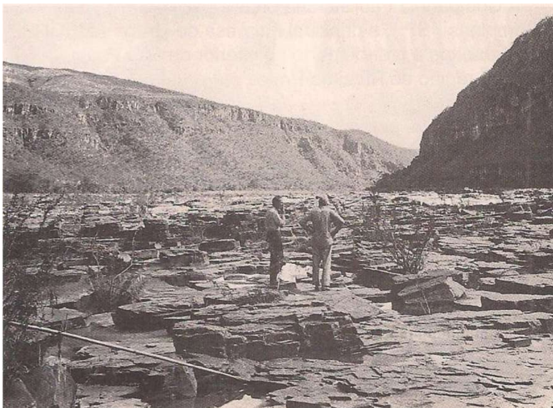
Imagem 2 – Noronha (esq.) e Anton Rydland (dir. – engenheiro norueguês contratado como consultor pela Cemig), ao se depararem pela primeira vez com o excepcional sítio para um projeto hidrelétrico Fonte: Cotrim (1994) (retornar para a página 46)
