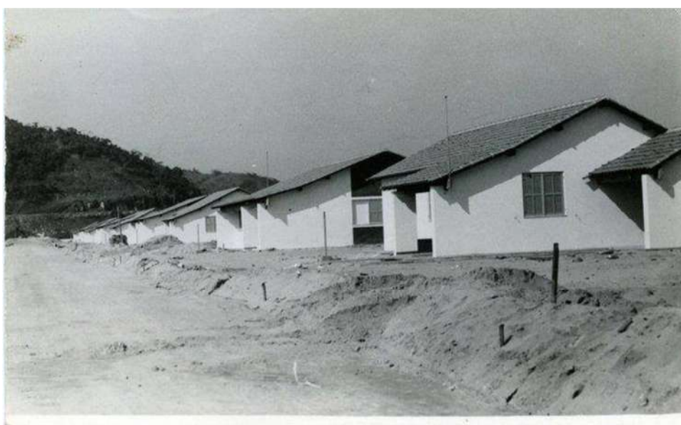
Imagem 50 – Construção da Vila Residencial de Mambucaba – Década de 1970 Fonte: arquivo Eletronuclear (retornar para a página 89)
