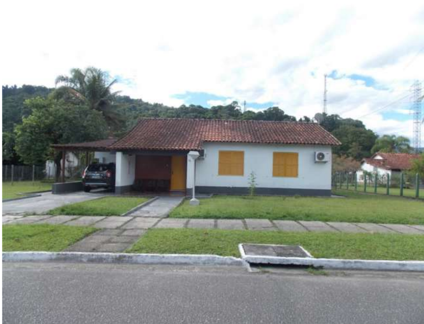
Imagem 31 – Tipo de residência C-A – alvenaria com três quartos, quarto de empregada, térrea com garagem Vila Residencial de Mambucaba. Fonte: arquivo pessoal
