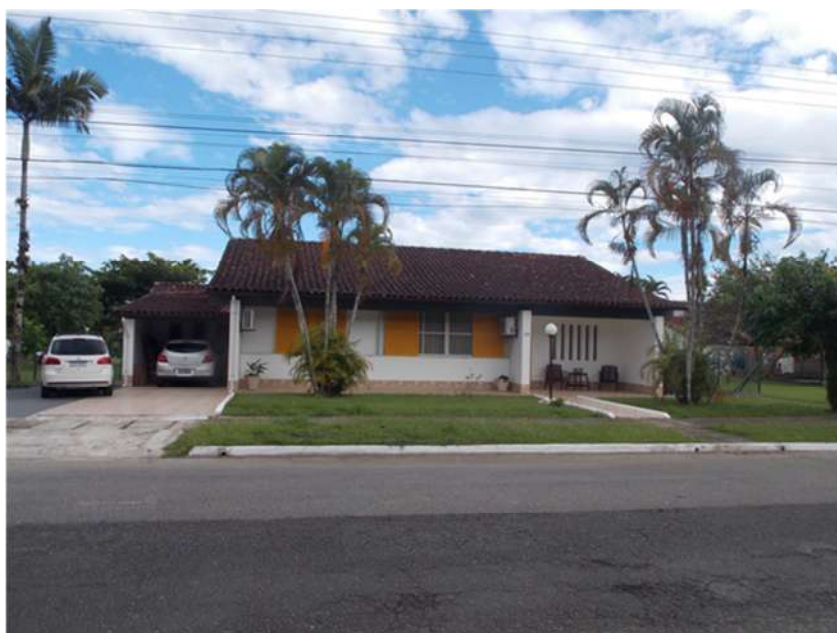
Imagem 34 – Tipo de residência B-A – alvenaria com três quartos, quarto de empregada, térrea com garagem Vila Residencial de Mambucaba. Fonte: arquivo pessoal
