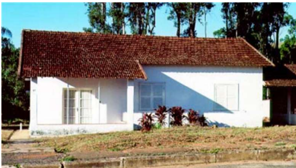
Imagem 25 – Imagem de casa do tipo T2 da Vila de Estreito Ilustra a expressão “casas antigas”.
