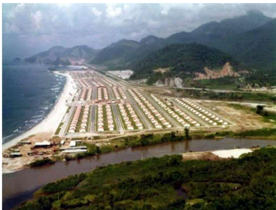
Imagem 53 – Vila Residencial de Mambucaba em fase de acabamento – Década de 1970 Na parte inferior, vista do Rio Perequê.
