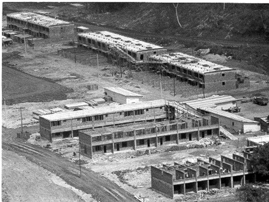
Imagem 47 – Construção da Vila Residencial de Praia Brava – Década de 1970 Fonte: arquivo Eletronuclear (retornar para a página 87)
